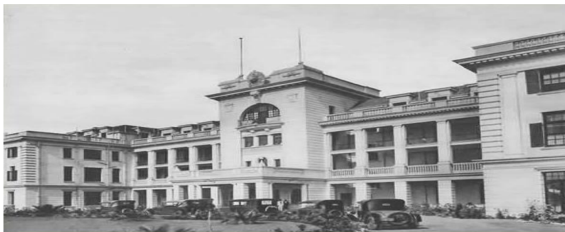
Figura 1: Fachada do Hotel Polana em 1929
