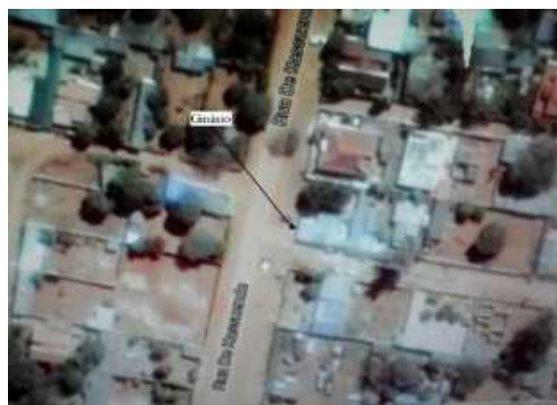
Figura 7: Vista de cima do “Ginásio”
