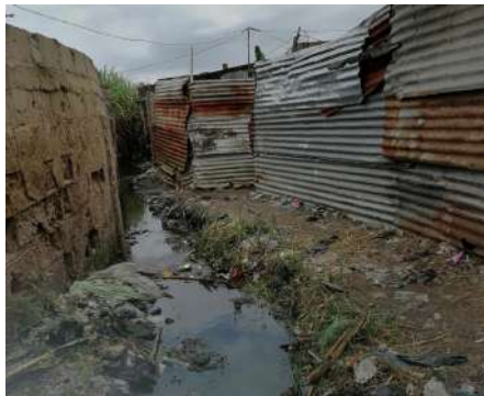
Imagem. - Acesso a Segunda Área de Maior Risco, Inacessível. Fonte: Autor.
