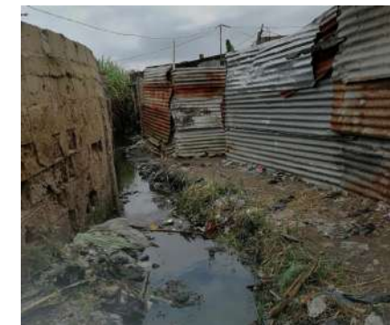
Imagem. 39 - Acesso a Segunda Área de Maior Risco, Inacessível.
