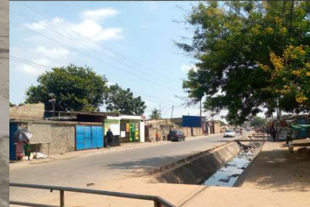
Imagem. 20 - Sistema de drenagem na Av. Milagre Mabote. Fonte: Autor.
