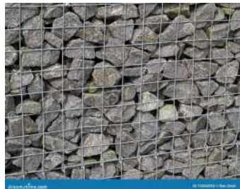
Fig.: Malha de contenção de pedra 3/4. Fonte: https://pt.dreamstime.com/foto-de-stock-rede-da-malha-do-ferro-de-gabion-com-pedras-pesadas-image73204293
