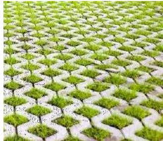
Fig.: Pavê drenante. Fonte: https://www.google.com/imgres?q=pav%C3%AA%20permeavel&imgurl=https%3A%2F%2Fapi.aecweb.com.br%2Ftematico%2Fimg_figuras%2Fpavimento-com-permeabilidade%24%
