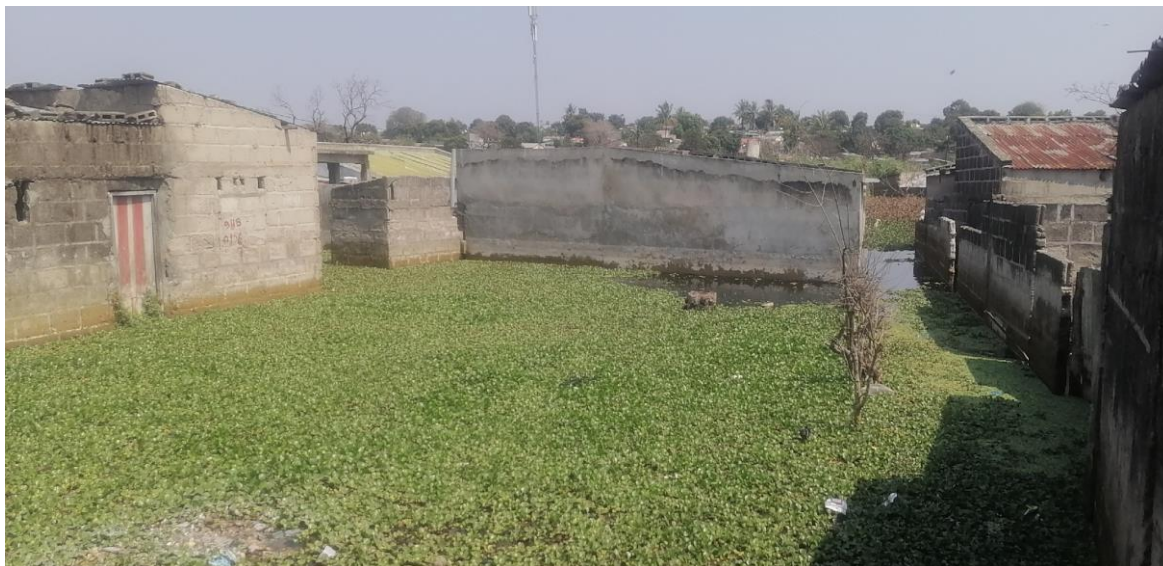
Figura 2. Ruas cheias de água e casas submersas e abandonadas no bairro de Hulene B
