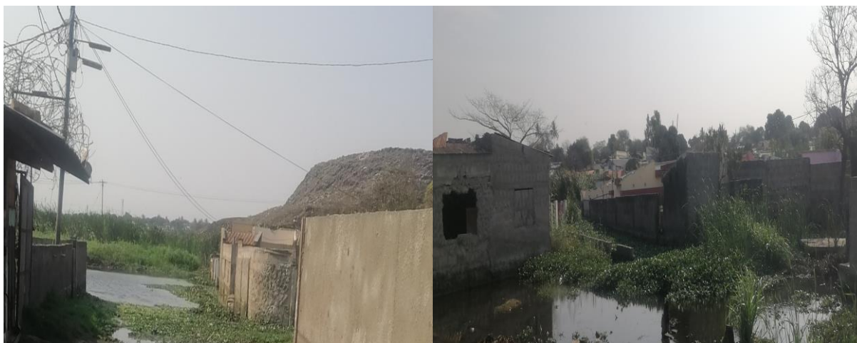
Figuras 4 e 5. Águas estagnadas, sem curso, resultado de falta de drenagem.
