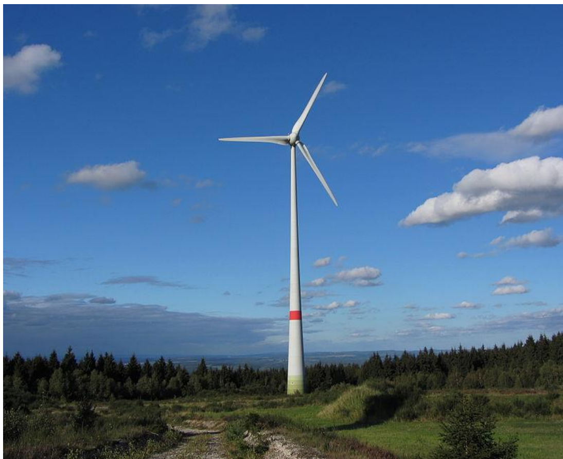
Figura 2. 12: Imagem ilustrativa de um aerogerador de eixo horizontal do tipo hélice (Haseirn, 2011).
