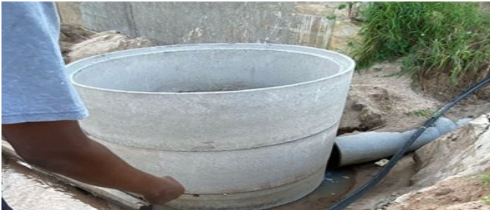
Imagem 2: Depósito de águas residuais.
