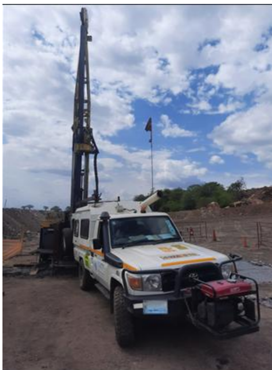
Figura 7: Processo de perfuração geofísica em furo de sondagem (Fonte: Autor, 2024)
