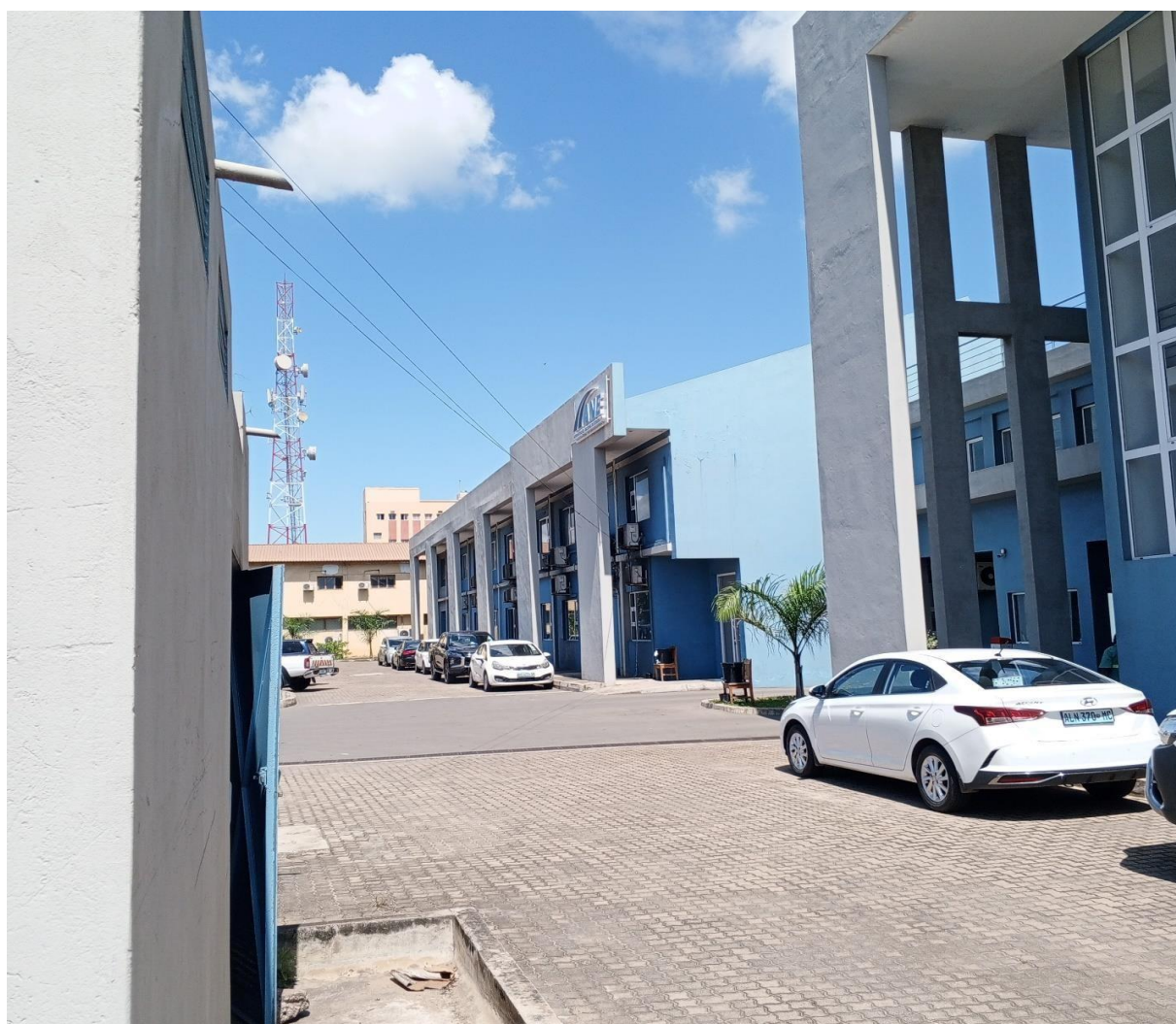
Figura 1. Vista frontal do edifício sede da ANE.
