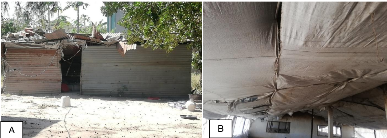
Figura XI: Ilustração do armazém – A; Ilustração do uso de sacos como isolantes internos – B.
