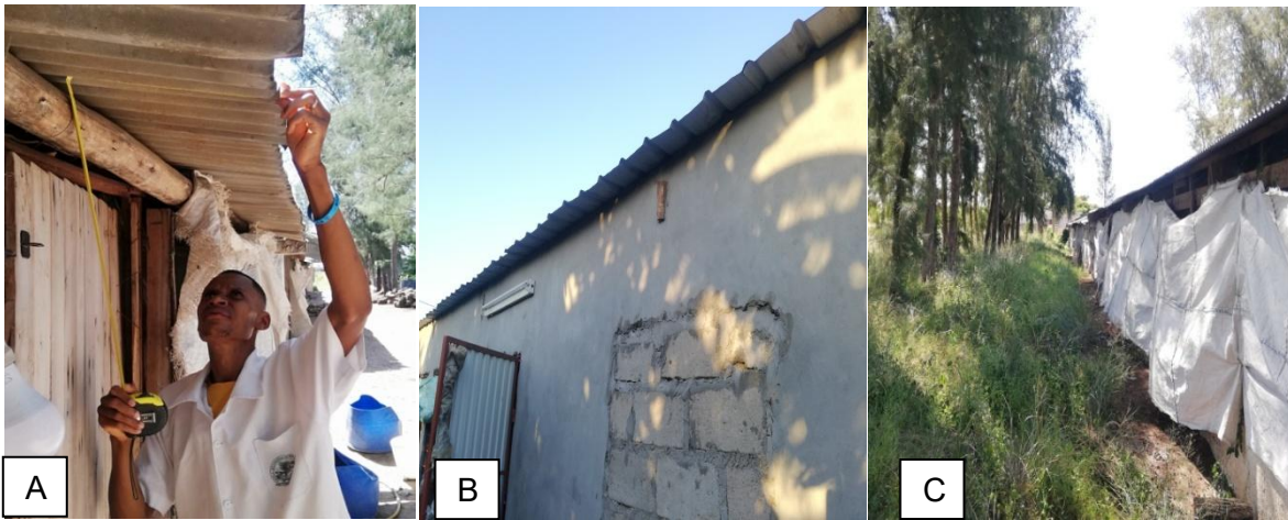
Figura X: Ilustração da medição do lanternim A; Ilustração do lanternim curto B; Ilustração das casuarinas como quebraventos C.
