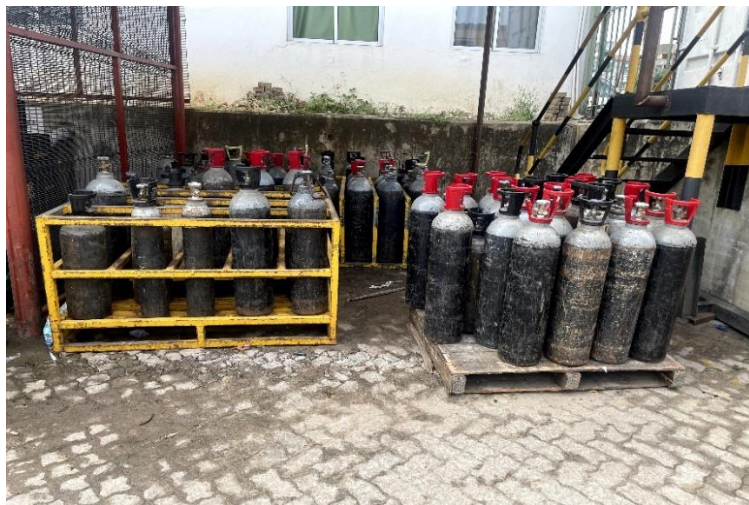
Figura 24- Gaiolas de armazenamento de cilindros de CO 2
