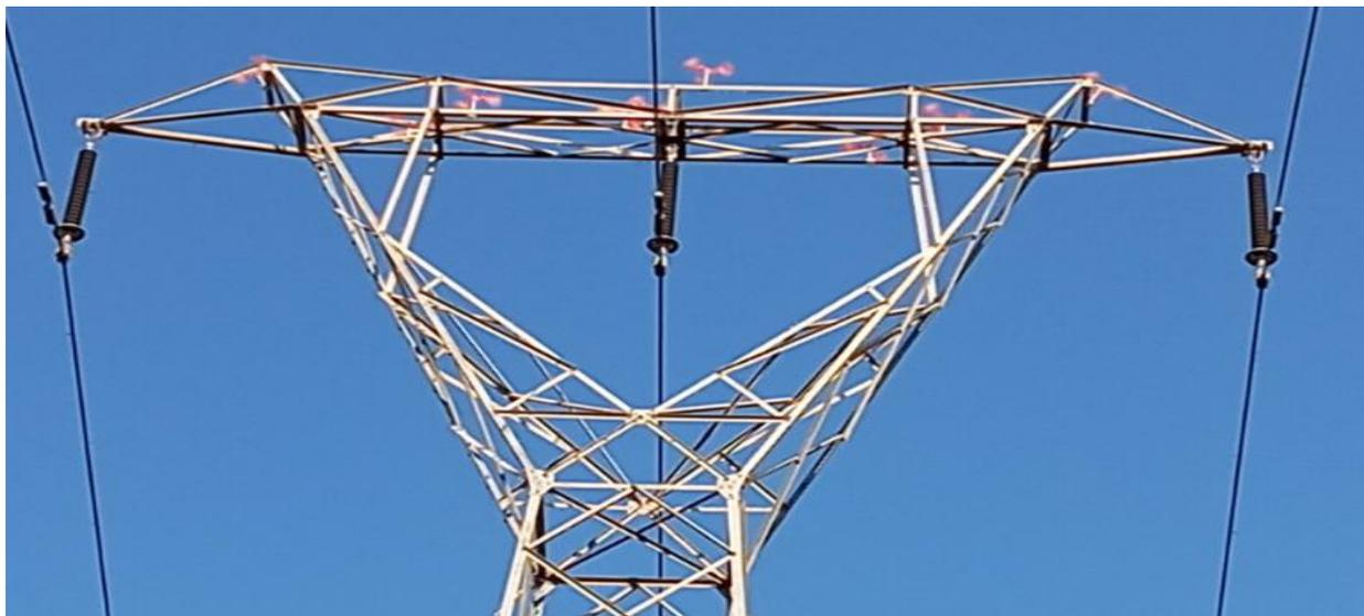
Figura 4: Torre com característica inviável para instalação de cabo de guarda. [Fonte: II].
