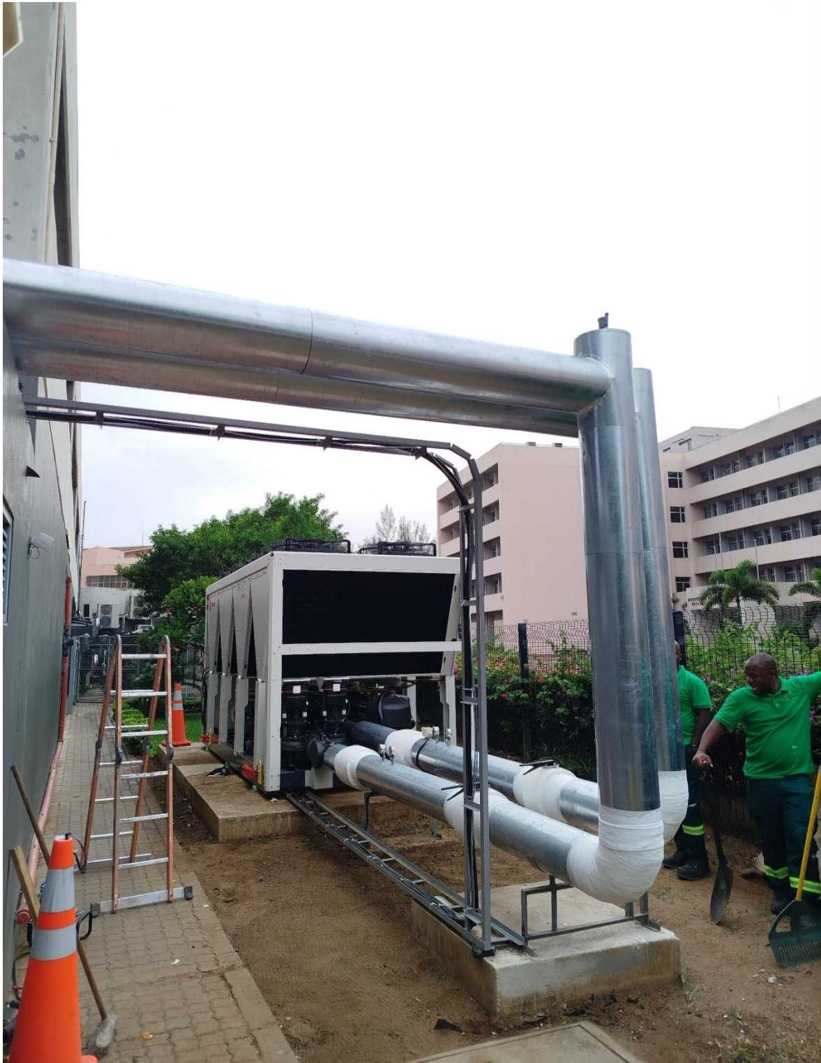
Figura A1-1: instalação do chiller de parafuso de ar comprimido
