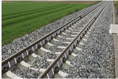
Figura 8: Balastro (Fonte: Sokisui, 2020)
