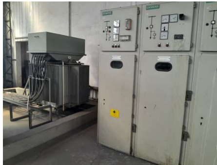
Figura 3: Manutenção preventiva (Fonte: Autor, 2025)
