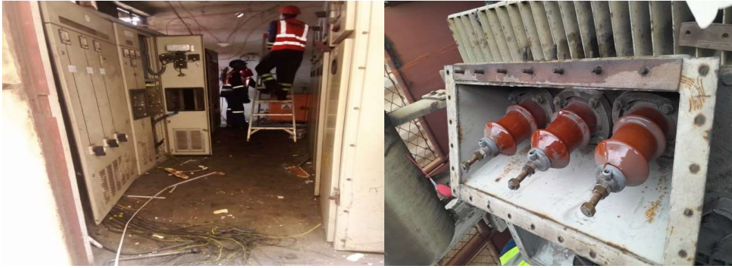
Figura 2: Desmantelamento de PTs (Fonte: Autor, 2025)
