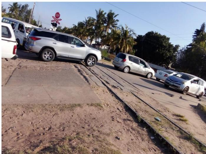
Figura 33: Desnível entre a ferrovia e a rodovia (Fonte: Autor)
