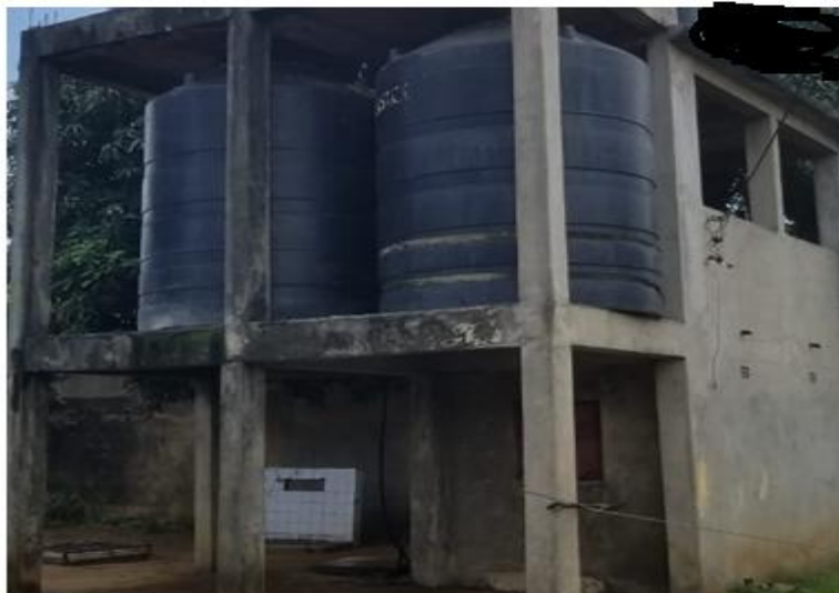
Figura 11: Sistema de distribuição obsoleto da água doce Iinducuzana
