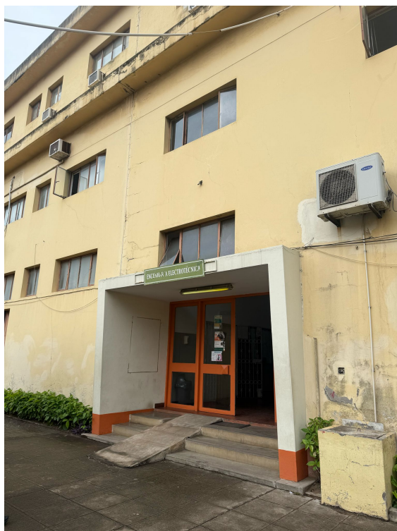
Figura 2.2: Imagem da entrada do Departamento de Engenharia Electrotécnica. Fonte: O autor (2025)
