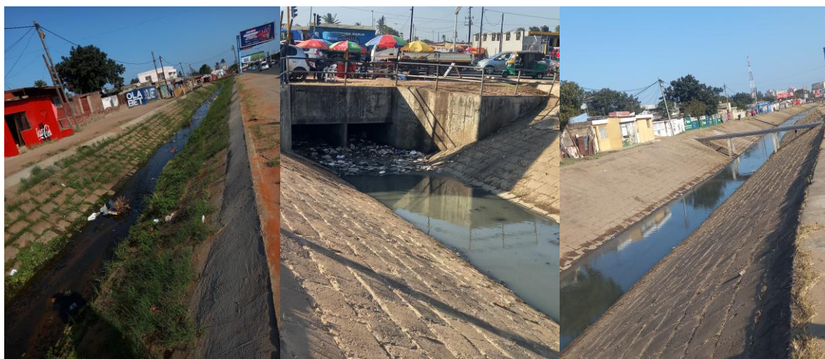
Figura 9- Vala da Avenida Acordos de Lusaka. Fonte: Autor.
