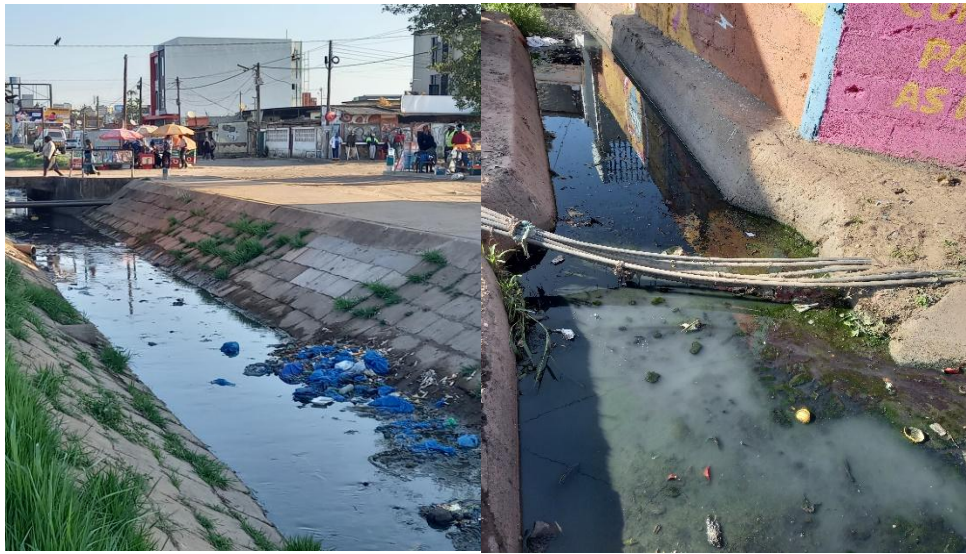
Figura 10- Vala da Avenida de Angola.
