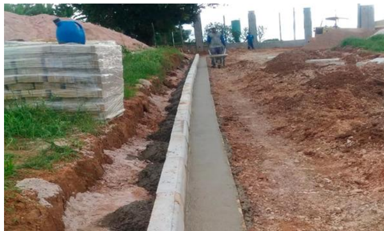
Figura 5- Guias e sarjetas.
