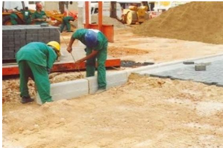
Figura 4- Guias sendo instaladas.
