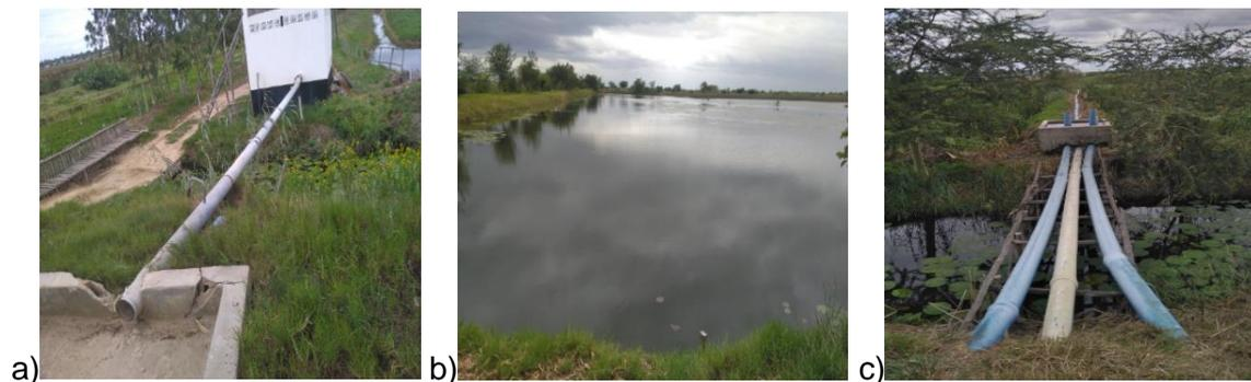
**Figura V:** **a.** Local de drenagem de águas residuais para tanques de sedimentação; **b.** tanque de sedimentação; **c.** Tubos de abastecimento de água proveniente de tanques de sedimentação.
