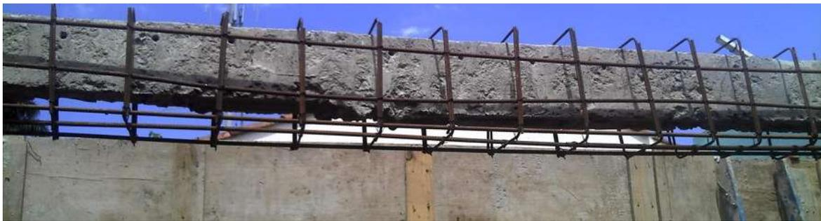
Figura 20 Reforço de uma viga recorrendo à adição de armaduras e betão (2)
