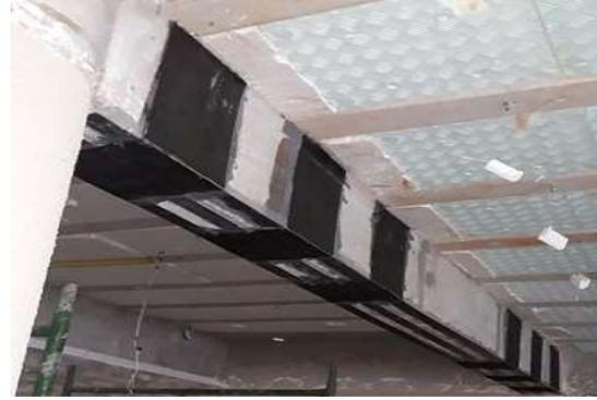
Figura 19 Reforço de uma viga recorrendo a aplicação de fibra de carbono
