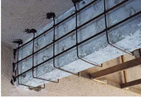
Figura 18 Reforço de uma viga recorrendo à adição de armaduras e betão (1)
