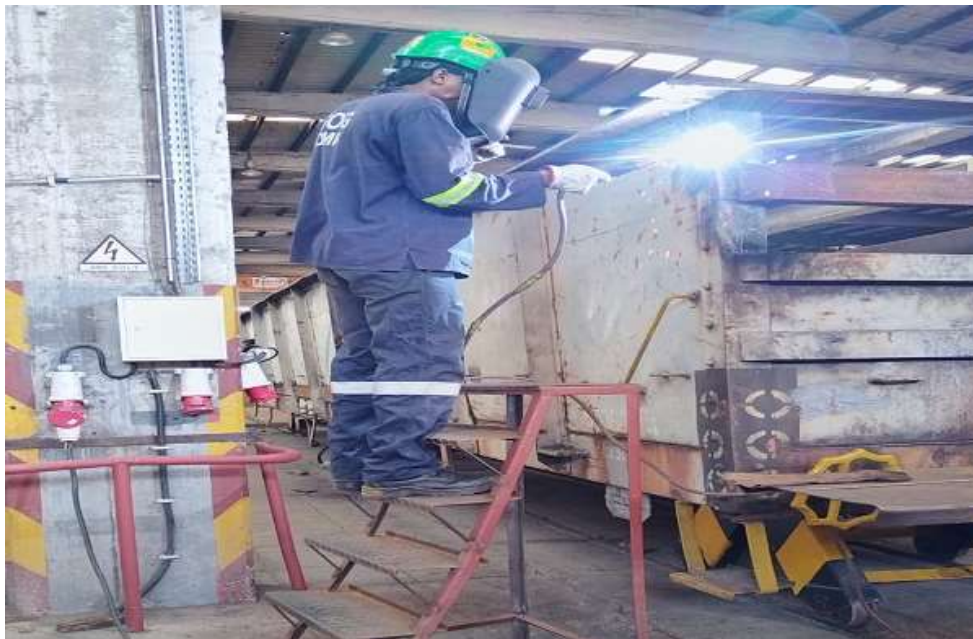
Figura 8: Soldadura de contraventamento
