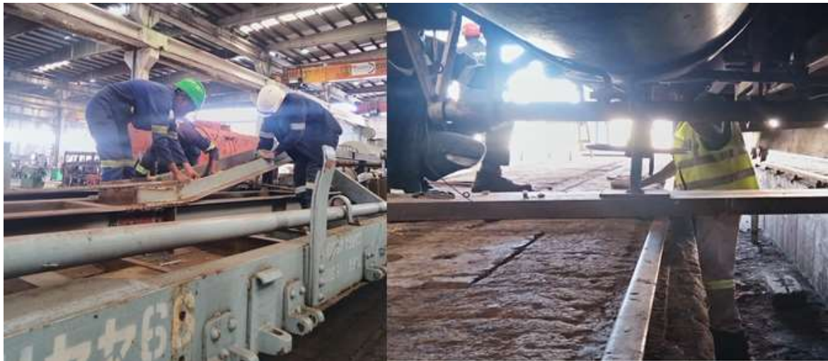
Figura 9: Processo da montagem da timonaria
