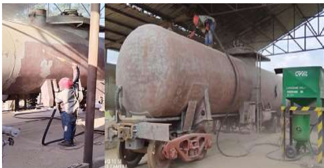
Figura 5: Decapagem vagão tanque-cisterna com jacto de ar comprimido e areia
