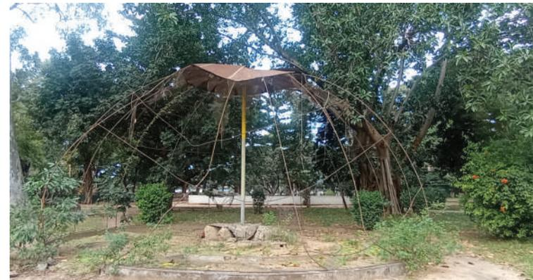
Figura 03. Estruturas danificadas pela falta de manutenção e exposição à intempérie (Alexsica Madepule)
