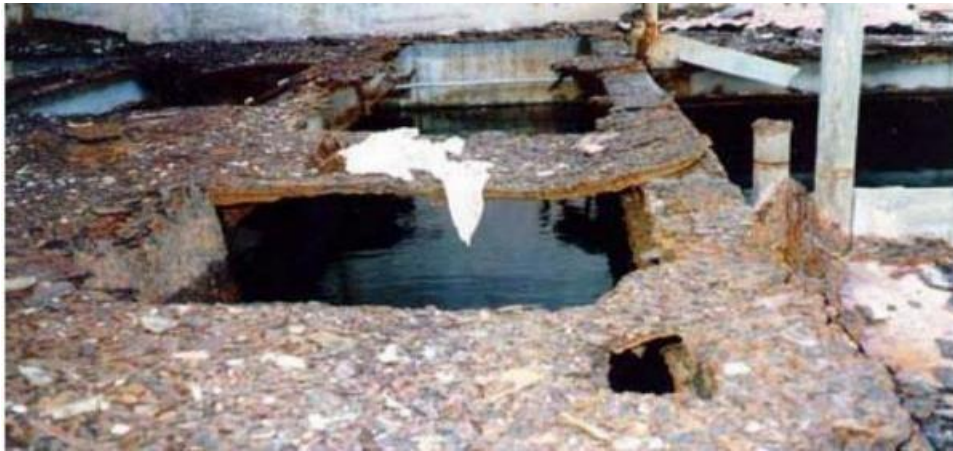
Figura 4. Corrosão Uniforme
