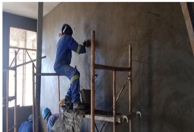
**Figura 10:** Reboco exterior
