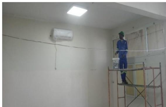
**Figura 6:** Pintura de paredes
