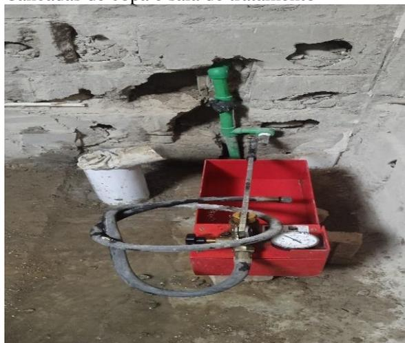
**Figura 4:** Ensaio de estanquidade
