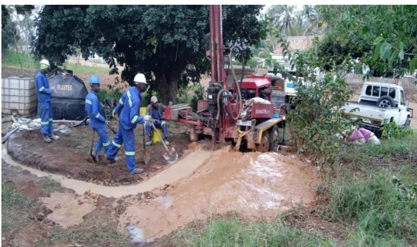
**Figura 17:** Execução de furo de água
