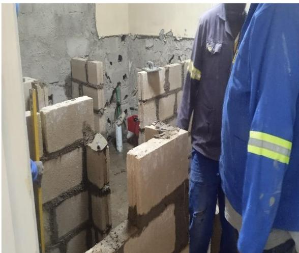
**Figura 3:** Assentamento de alvenarias na nova casa de banho
