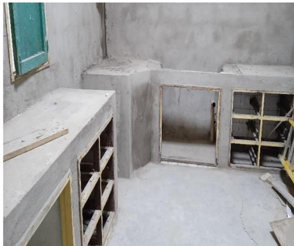
**Figura 2:** Substituição de revestimento em bancadas de copa e sala de tratamento
