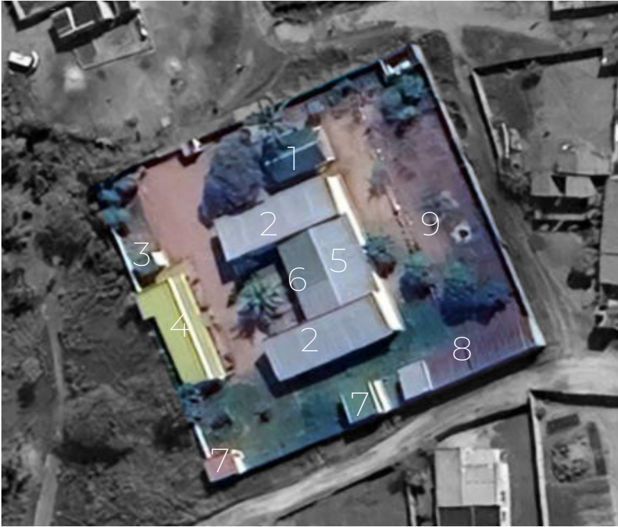
Centro de acolhimento nhamai NKOBE-Implantação Fonte: O Autor
