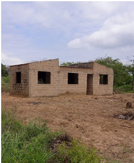
Tipo de Habitação Local em obra fonte: o Autor 2024
