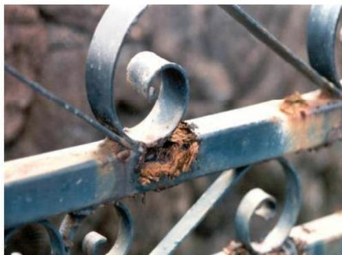
*Figura 10: Exemplo de corrosão cavernosa. Fonte: Apontamentos de Soldadura e Protecção de metais UEM-FE Prof. Dr Engº Justino B. Mulima*
