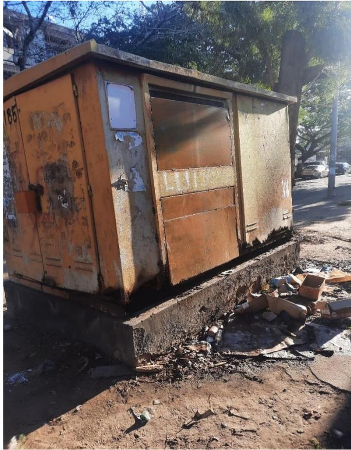
*Figura 27: PT com ataque corrosivo.*
