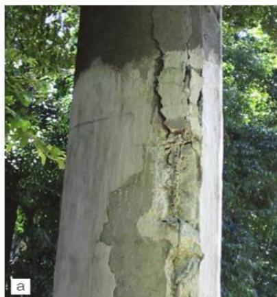
*Figura 19: Exemplo de corrosão química, fonte: Apontamentos de Soldadura e Protecção de metais UEM-FE Prof. Dr Engº Justino B. Mulima*
