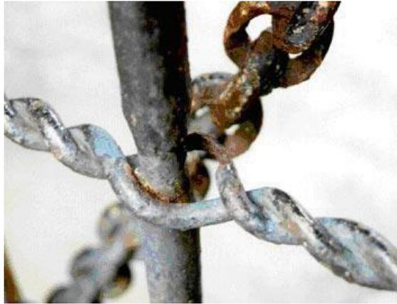
*Figura 16: Exemplo de corrosão por fricção*
