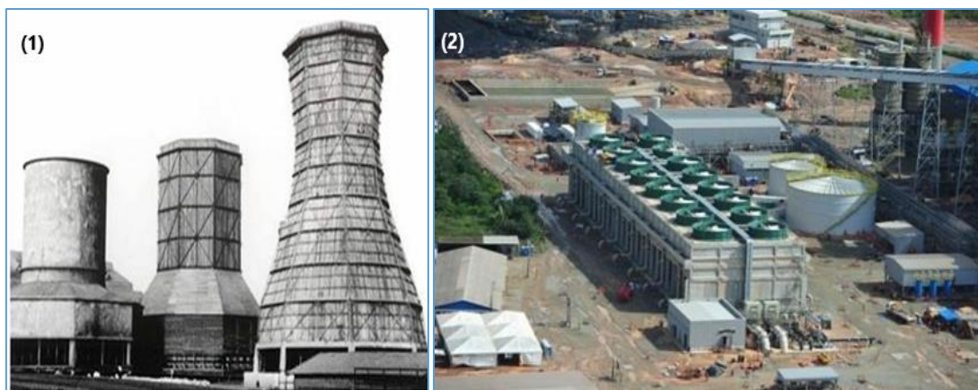
Figura 7. Modelos antigos (1) e modernos (2) de torres de resfriamento de tiragens natural e mecânica em série, respectivamente
