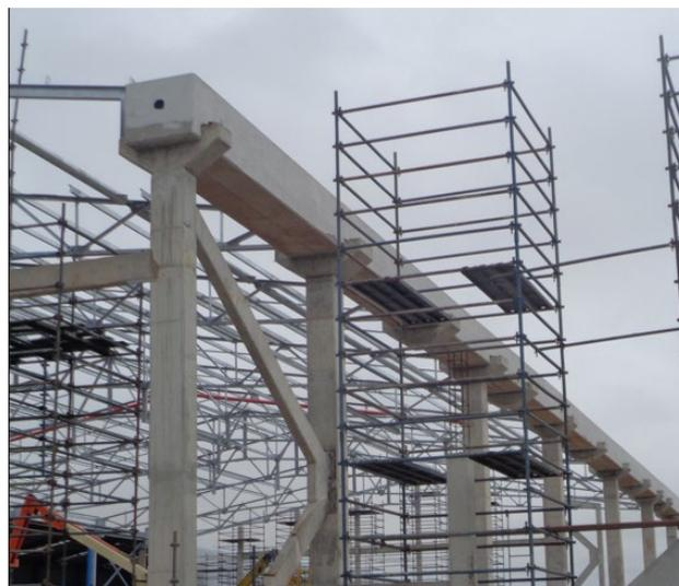
Figura 83 - Desmoldagem da viga-caleira
