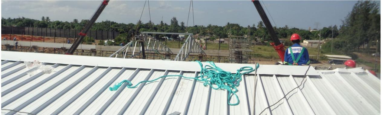
Figura 117 - *Flashings* transversais
