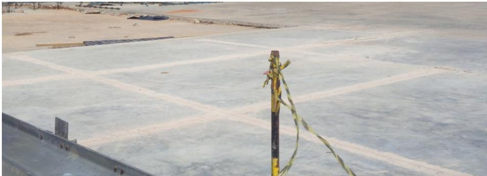
Figura 91 - Juntas de retracção ou serrada
