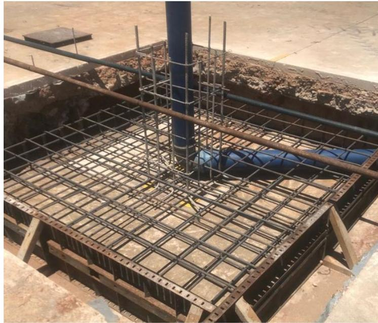
Figura 47: Ilustração dos tubos de queda na fundação
