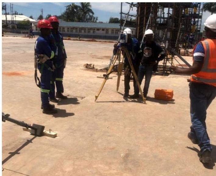
Figura 66 - Verificação da verticalidade dos pilares com recurso a teodolito
