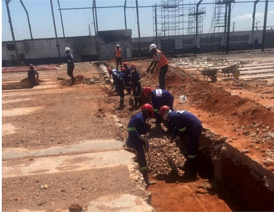
Figura 33 - Aplicação do enrocamento na fundação
