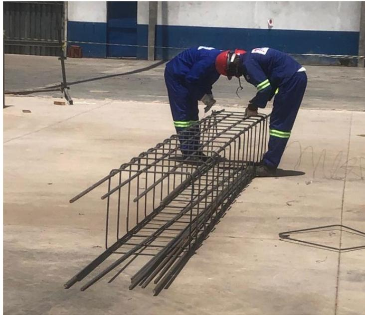
Figura 55 - Amarração da armadura dos pilares
