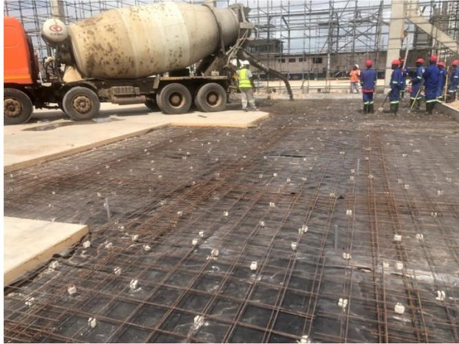
Figura 89 - Betonagem do pavimento
