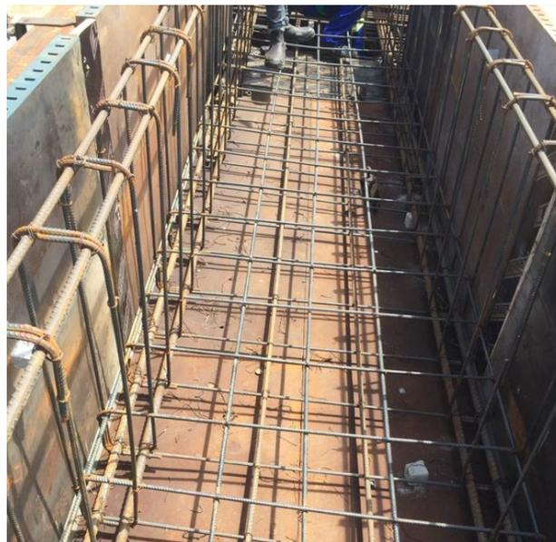
Figura 78 - Amarração das armaduras da viga-caleira
