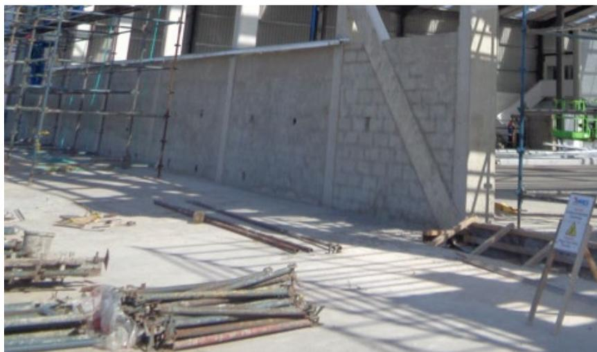
Figura 102 - Execução do chapisco na alvenaria
