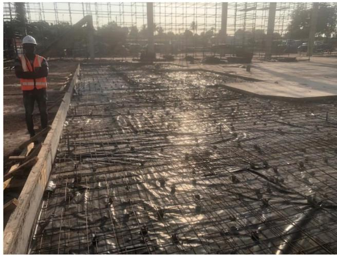
Figura 88 - Preparação do pavimento a ser betonado
