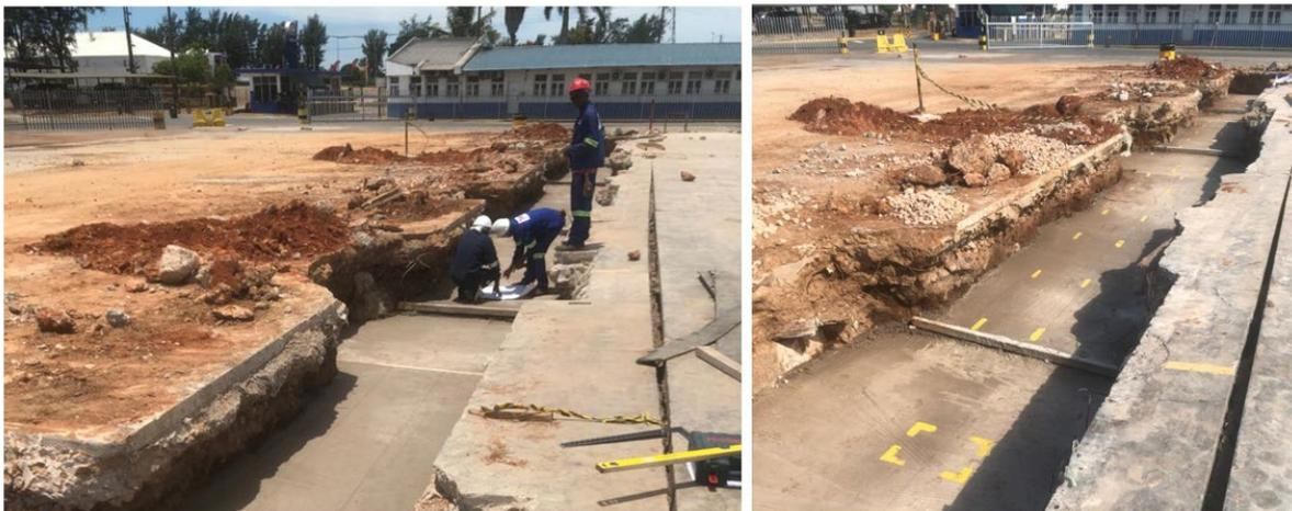
Figura 44 - Marcação da localização das barras de aço sobre o betão de limpeza
