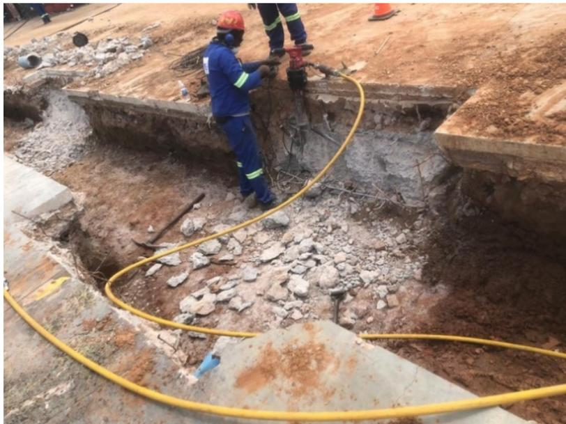
Figura 29 - Demolição da estrutura existente
