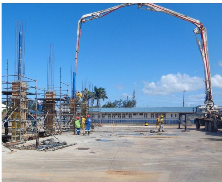
Figura 67 - Betonagem de pilares com recurso a bomba
