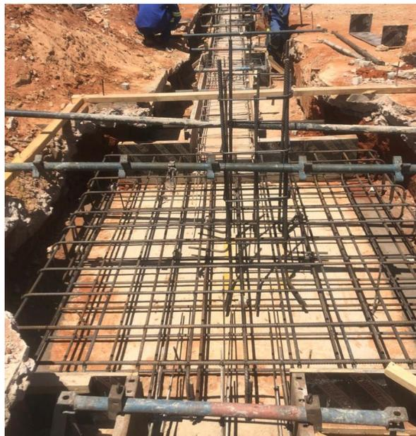
Figura 46 - Montagem da cofragem
