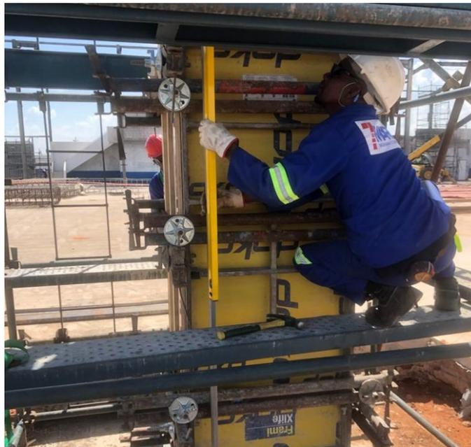
Figura 65 - Nivelamento dos pilares
