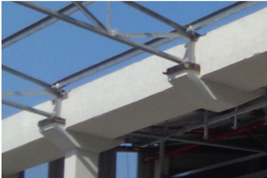
Figura 108 - Sistema de apoio da treliça de cobertura
