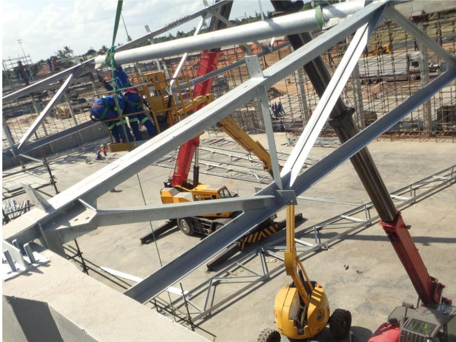
Figura 114 - Aperto de um dos contraventamentos horizontais
