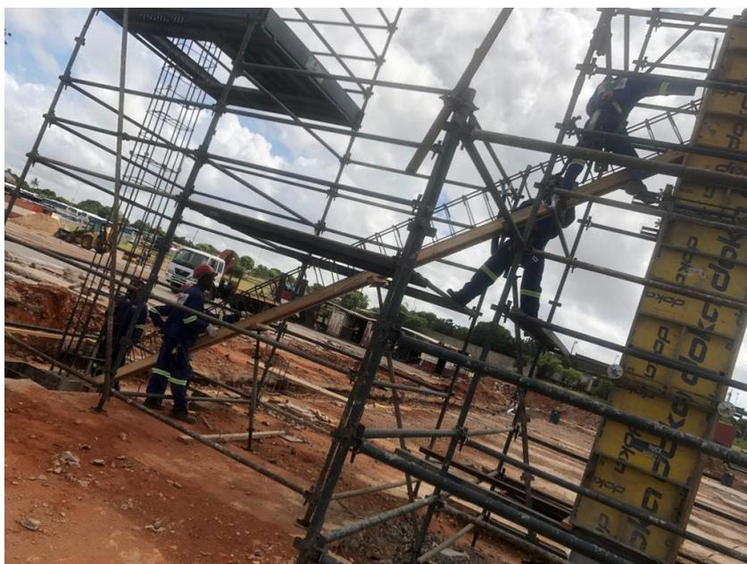
Figura 71 - Posicionamento das armaduras dos contraventamentos em betão armado
