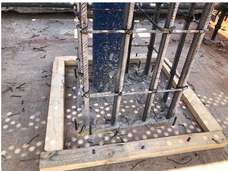
Figura 53 - Processo de marcação dos pilares
