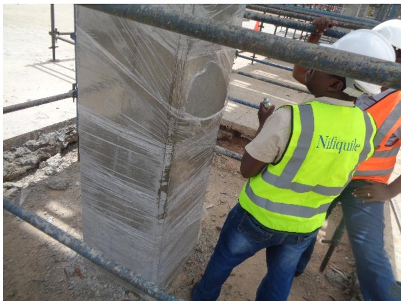
Figura 23 - Ensaio esclerométrico num dos pilares
