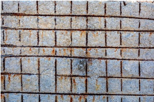
Figura 7 - Exemplo de corrosão das armaduras
