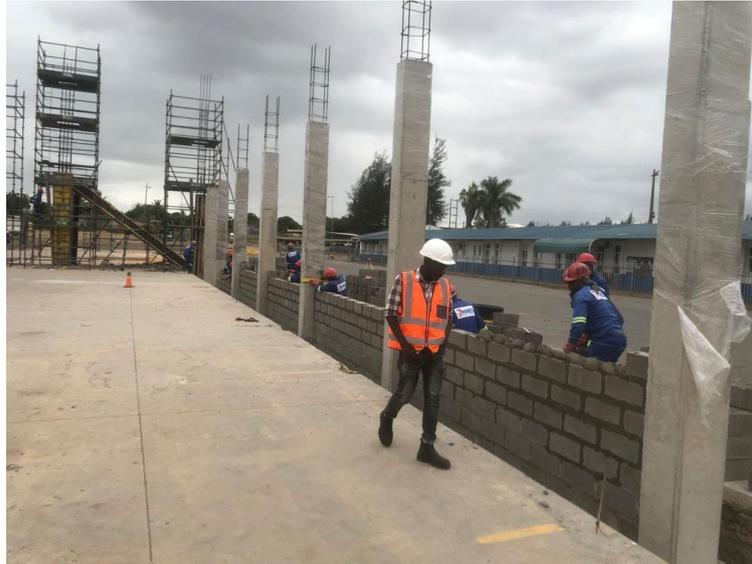
Figura 96 - Execução da alvenaria
