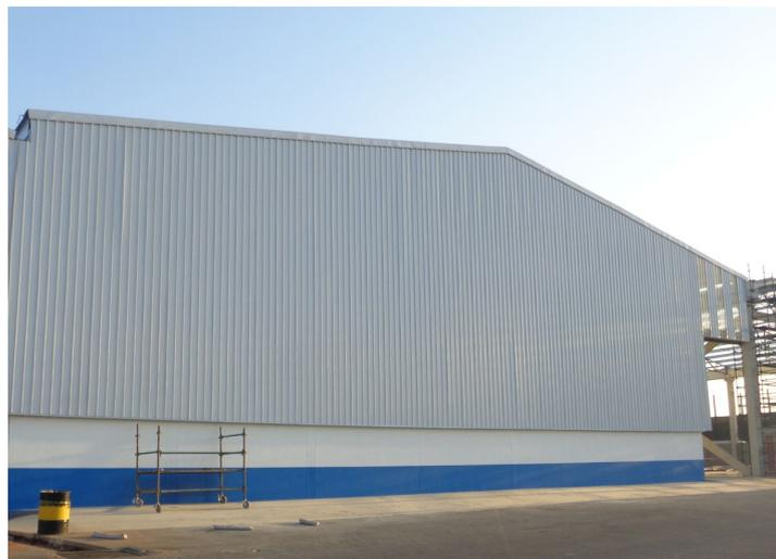
Figura 104 - Revestimento lateral com chapas de zinco
