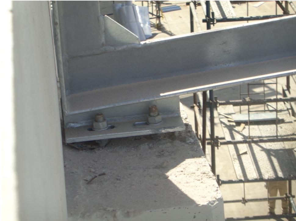
Figura 113 - Apoio B sobre a consola
