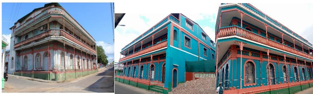
Figure 2: a, b, c Vistas diferentes da Casa Oswald Hoffman Fonte: Chauque (2023)
