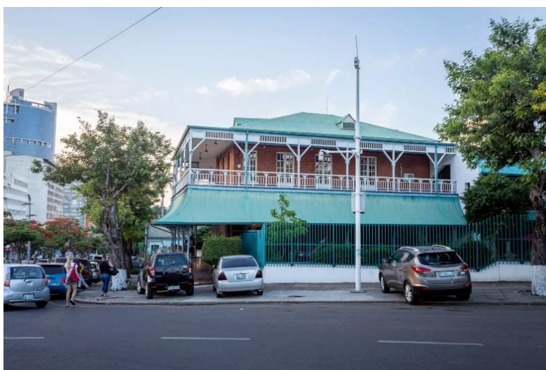
Figura 4: Edifício do CCFM Fonte https://www.ccfmoz.com/o-centro/
