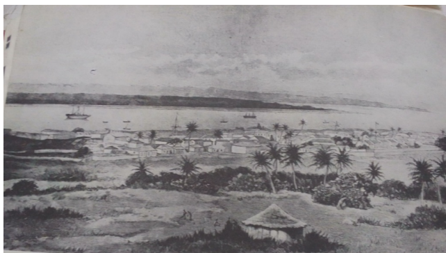
iii: A Cidade vista do começo da maxaquene, por alturas da escola correias Silva, vendo-se o hospital provisório de barracas desmontáveis, e a igreja em construção (Lobato, 1970:173)
