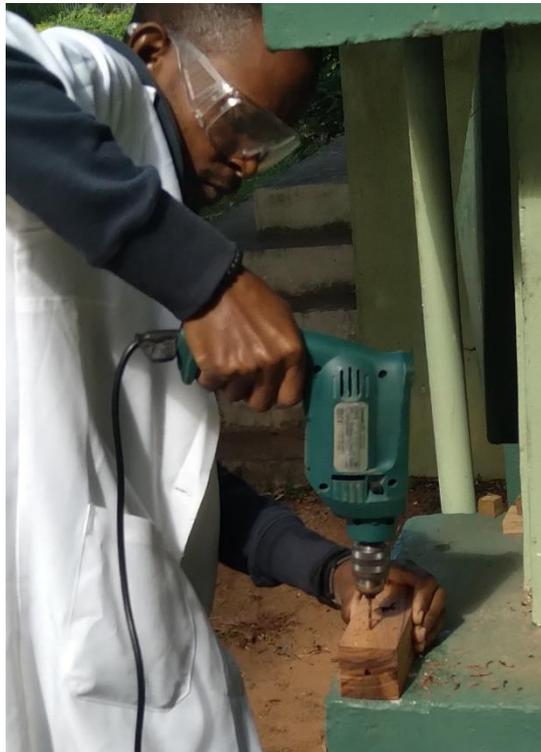
Figure 13. *Imagem ilustrativa do processo da pré-furação na madeira.*
