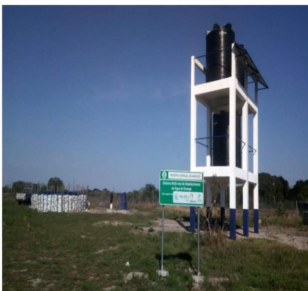
**Figure 2.** Tanques de abastecimento de água para consumo domiciliar
