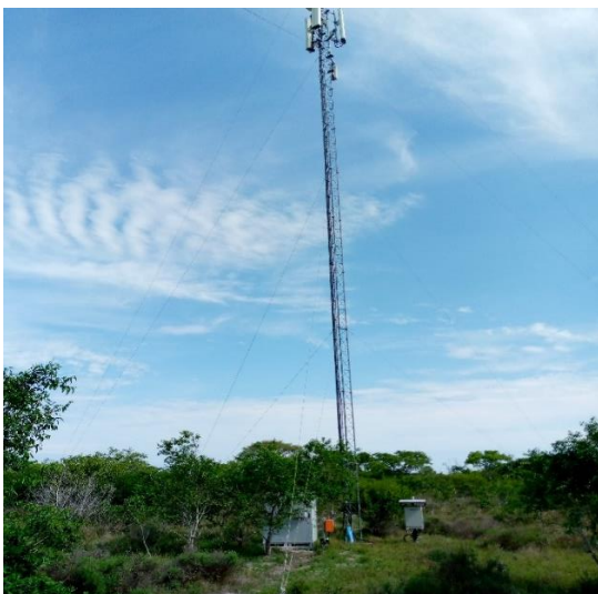
Figura 9: Torre de comunicação
