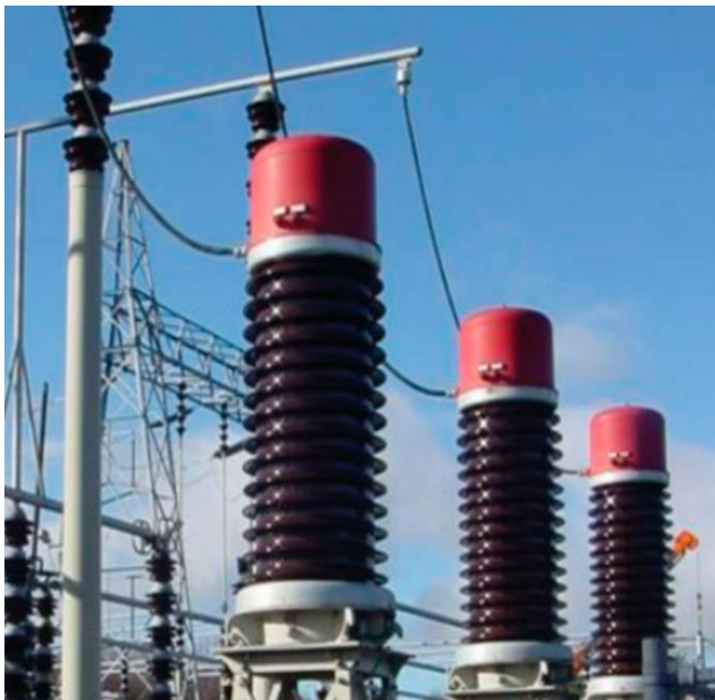
Figura 9: Transformador de tensão e respectivo símbolo (Fonte: Santos, 2018)
