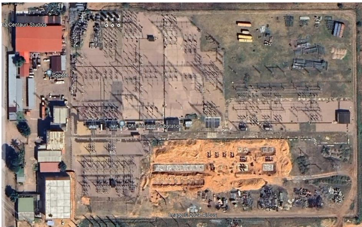
Figura 1: Vista a satélite da Subestação de Infulene (Fonte: Google earth, 2024)
