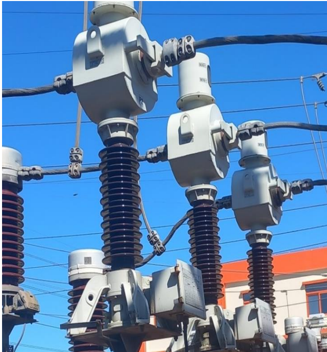
Figura 8: Transformador de corrente e respectivo símbolo (Fonte: O Autor, 2024)
