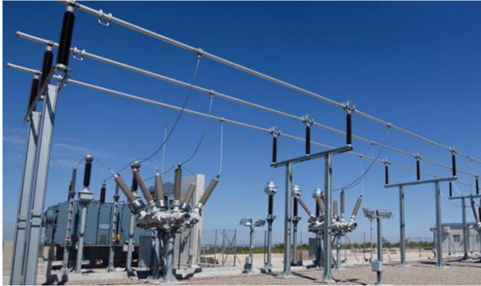
Figura 10: Barramento tubular rígido (Fone: Cormec, 2020)
