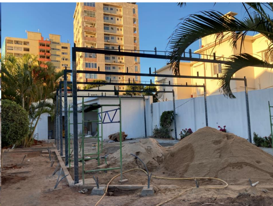
Figura 34 – Montagem de vigas metálicas sobre os pilares (Fonte: Própria)
