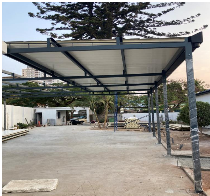
Figura 35 – Montagem das chapas sobre a estrutura metálica (Fonte: Própria)
