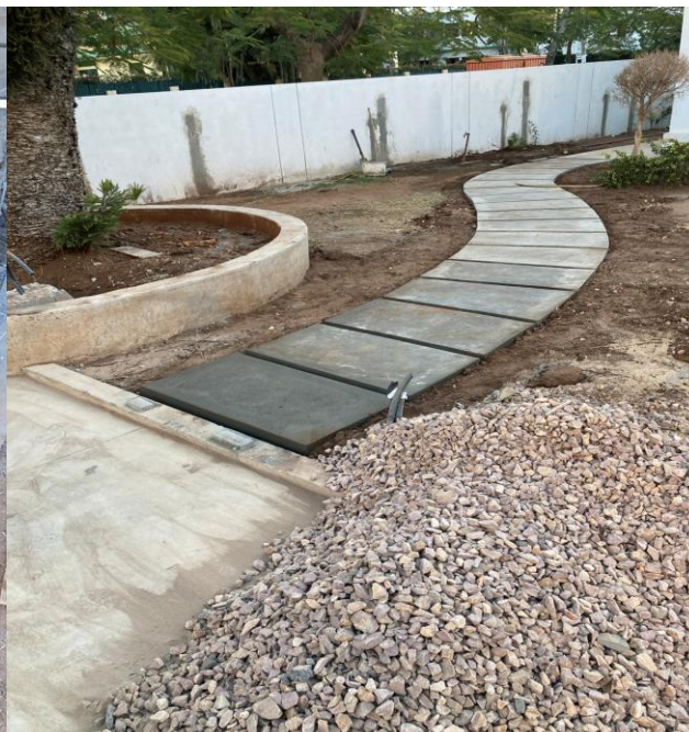
Figura 26 – Regularização das lajetas (Fonte: Própria)
