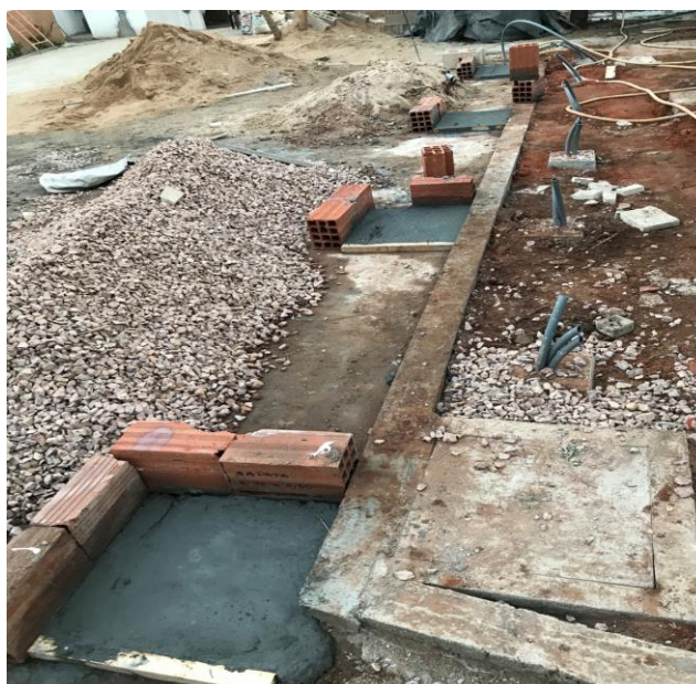
Figura 32 – Betonagem dos maciços (Fonte: Própria)
