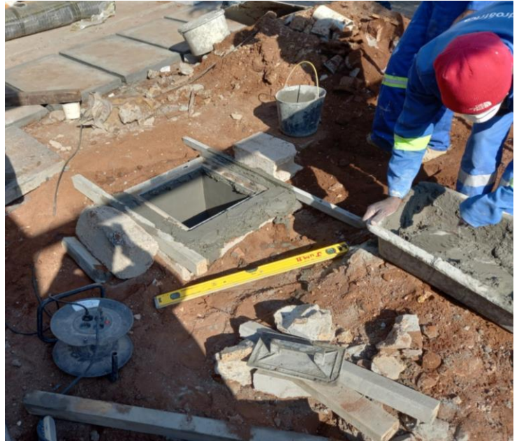
Figura 29 – Regularização da caixa (Fonte: Própria)
