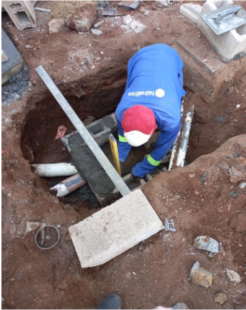
Figura 28 – Elevação da estrutura da caixa (Fonte: Própria)
