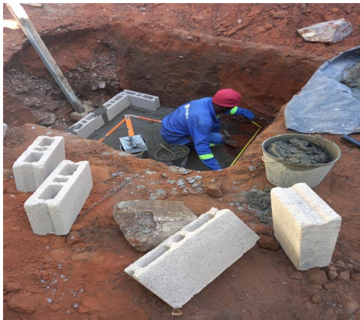
Figura 20 – Assentamento de blocos da caixa de retenção de gorduras (Fonte: Própria)
