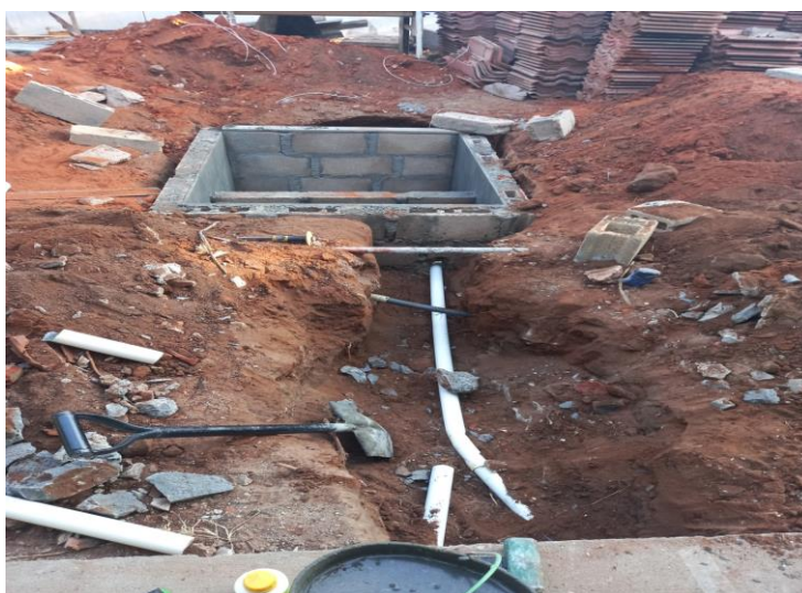
Figura 21 – Reboco da caixa de retenção de gordura (Fonte: Própria)
