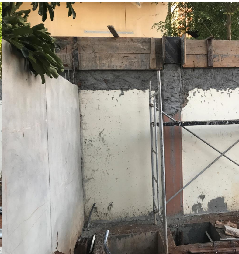
Figura 17 – Cofragem da viga do (Fonte: Própria)
