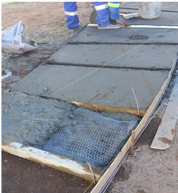
Figura 25 – Betonagem das lajetas (Fonte: Própria)
