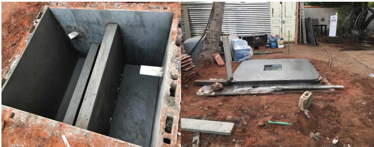
Figura 22 – Reboco da caixa (Fonte: Própria)
