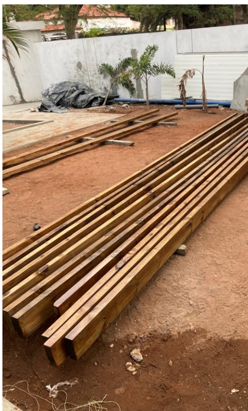
Figura 36 – Envernizamento de barrotes de madeira (Fonte: Própria)
