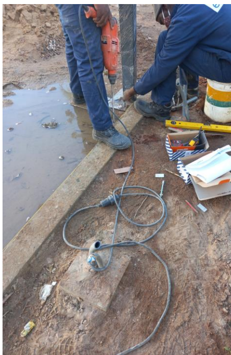
Figura 33 – Assentamento de pilares metálicos sobre as fundações (Fonte: Própria)
