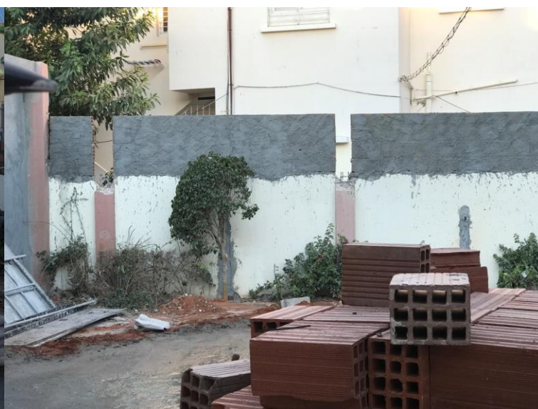
Figura 12 – Chapisco e reboco do muro (Fonte: Própria)
