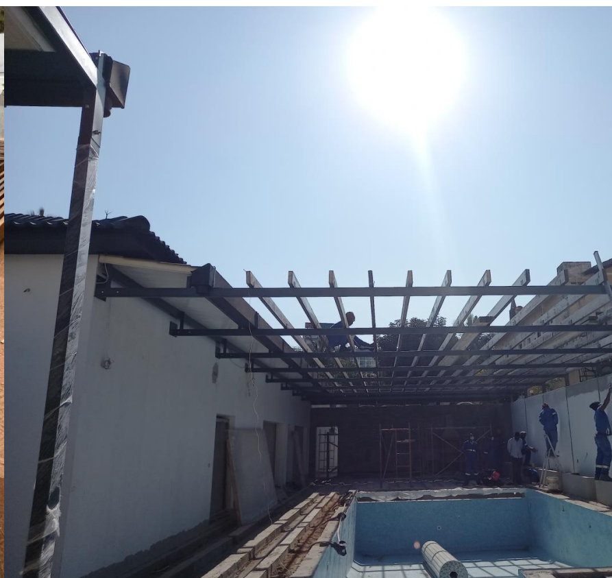
Figura 37 – Assentamento dos barrotes sobre a estrutura metálica (Fonte: Própria)
