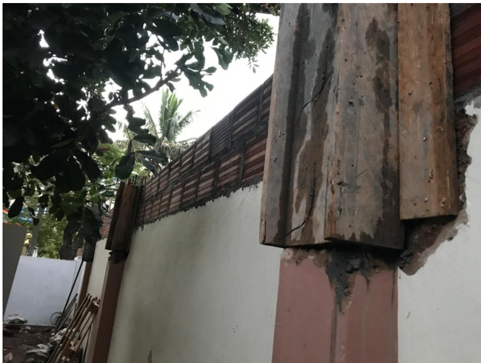
Figura 15 – Betonagem dos pilares (Fonte: Própria)
