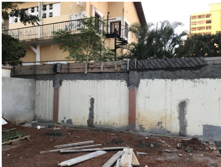
Figura 18 – Betonagem da viga (Fonte: Própria)
