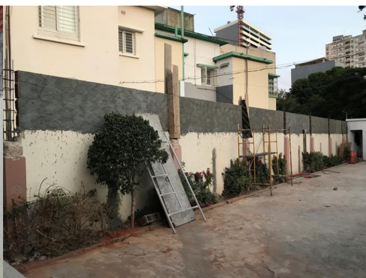
Figura 14 – Cofragem dos pilares (Fonte: Própria)
