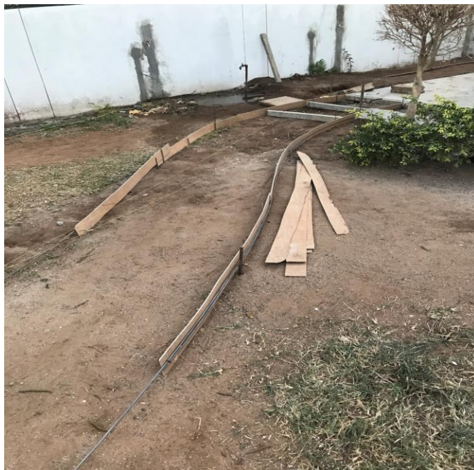
Figura 24 – Delimitação, marcação e cofragem do passadício (Fonte: Própria)
