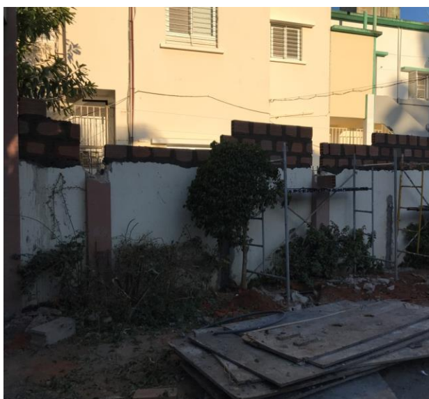
Figura 11 – Elevação do muro com blocos cerâmicos (Fonte: Própria)
