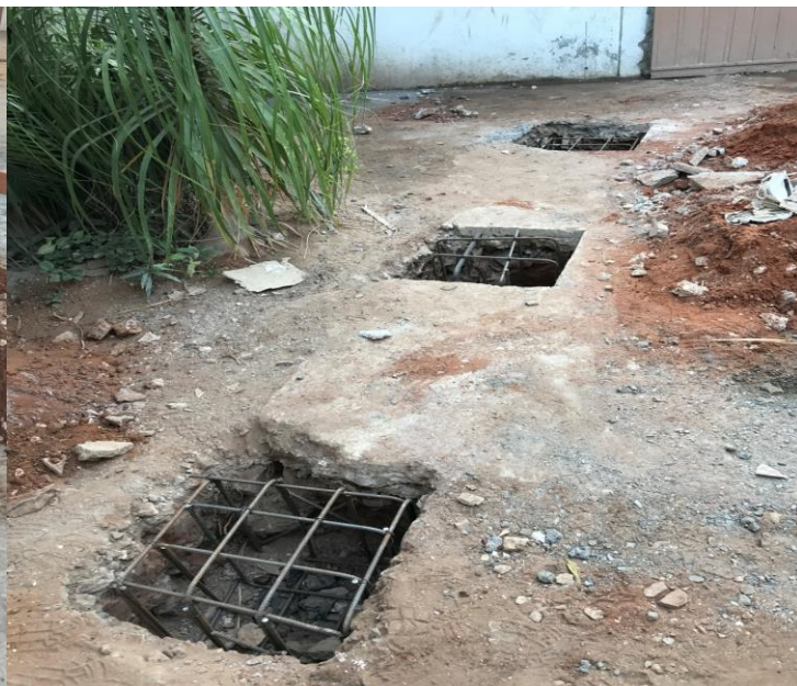
Figura 31 – Aplicação de armaduras (Fonte: Própria)
