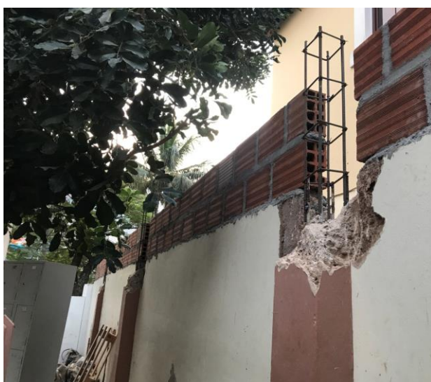
Figura 13 – Demolição e extensão das armaduras (Fonte: Própria)
