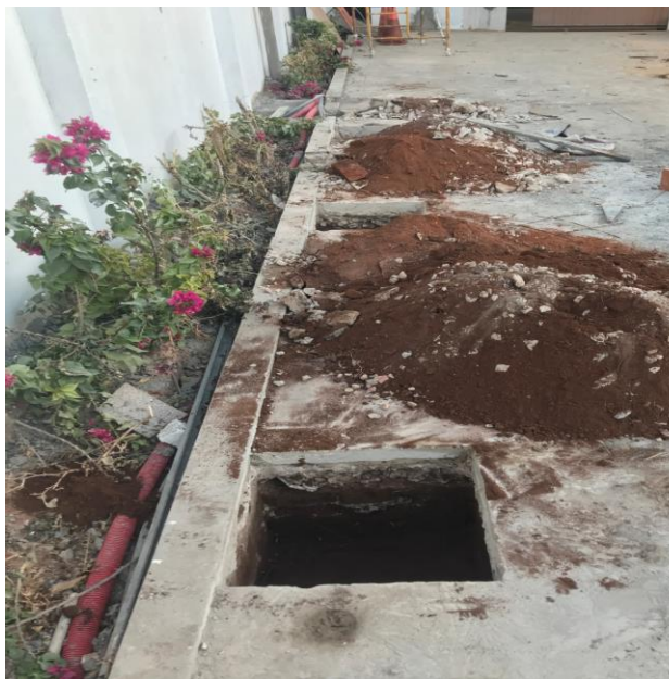
Figura 30 – Abertura de cabocos (Fonte: Própria)
