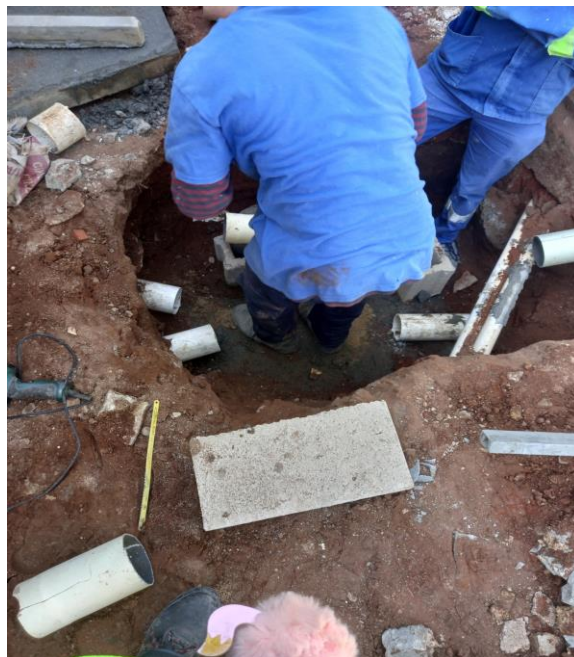
Figura 27 – Posicionamento dos tudos de escoamento (Fonte: Própria)
