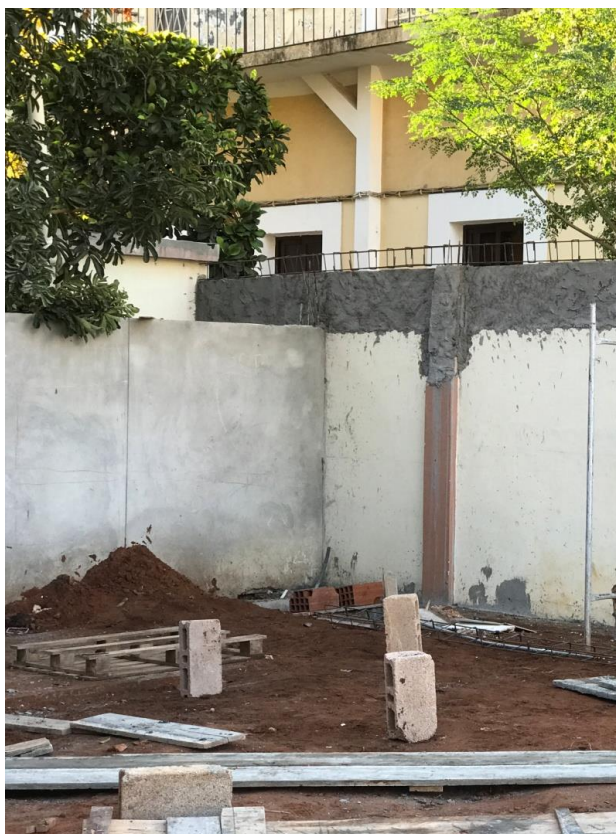
Figura 16 – Colocação de armaduras da viga (Fonte: Própria)
