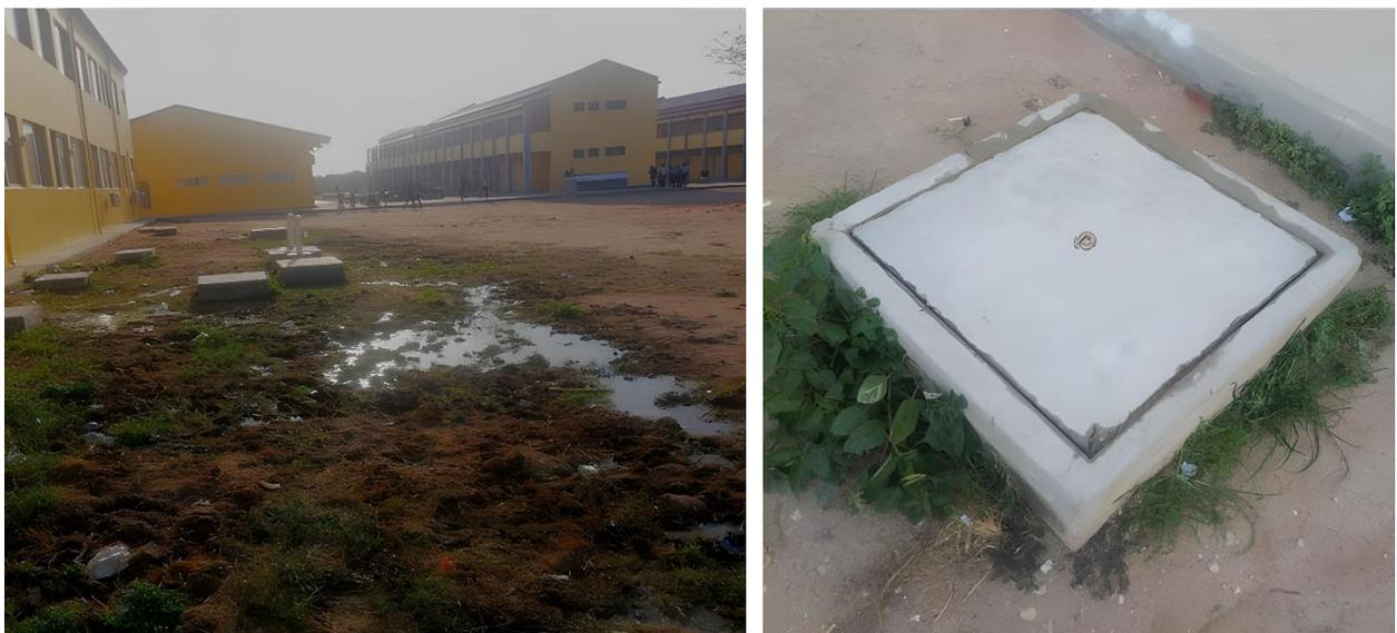
**Figura 4. 6** – Ilustração do estado do sistema de drenagem da Escola Secundária de Chinonanquila nos blocos em que o mesmo não estava em funcionamento
