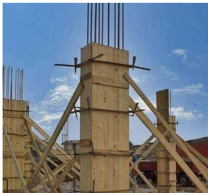
**Fig.47:** Cofragem de pilares de concreto com madeira. Fonte: Alsina.
