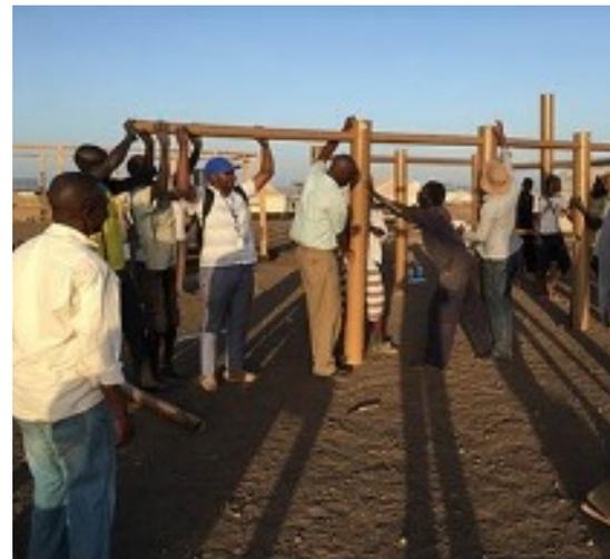
**Fig.75:** Montagem de colunas e vigas em tubo de papelão. Fonte: Shigeru Ban Architects
