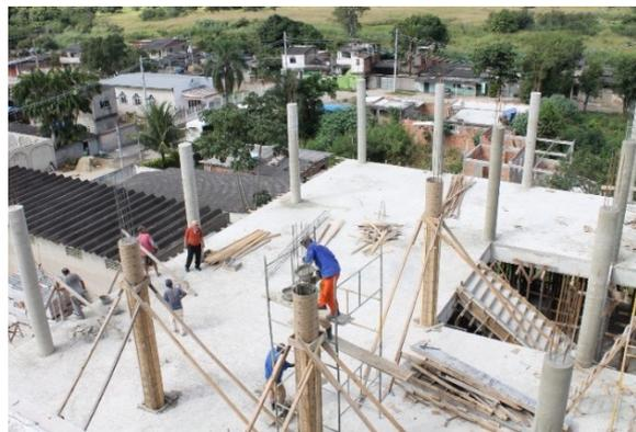
**Fig.48:** Cofragem de pilares de concreto com tubos de papelão. Fonte: Pentapak.
