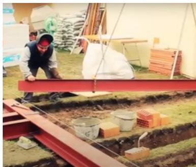
**Fig.64:** Construção da estrutura metálica de fundação do pavilhão temporário The IE Paper Pavilion, 2013. Fonte: IE Business School (2013). "Timelapse video: The IE Paper Pavilion (Shigeru Ban)" [Vídeo].
