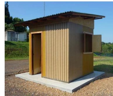
**Fig.67:** Vista exterior do edifício de Proposta de vedação vertical com tubos de papelão de Gerusa Salado, 2011. Fonte: Gerusa Salado.
