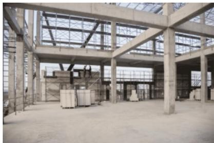
**Fig.38:** Pilares e vigas em concreto armado. Fonte: S3DA design.
