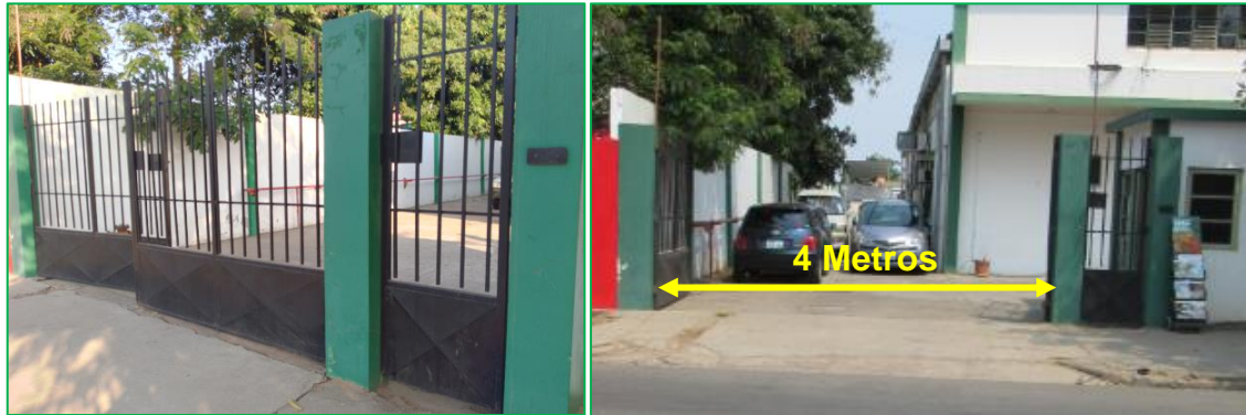
Figura 4: Portão principal de acesso
