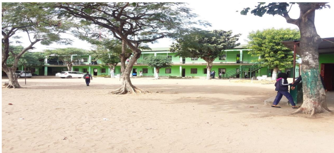
Figura 12: Vista frontal da Escola Comunitária Nossa Senhora do Livramento T-3. Fonte: O Autor
