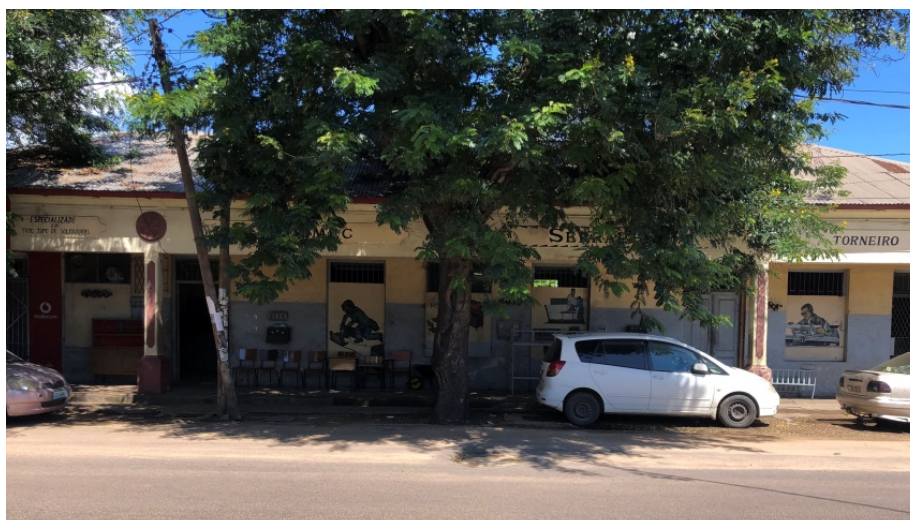
Figura 8:Instalações da SERTORMEC
