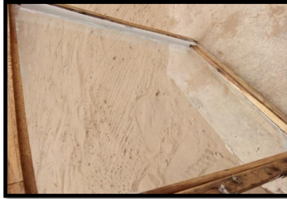
Figura 9 — Estrutura de cobertura
