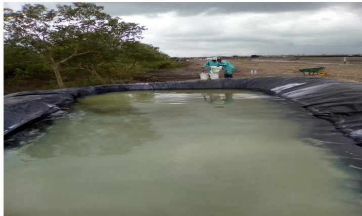
Figura 15: Neutralização de MBS na lagoa de estabilização – Fonte: A autora
