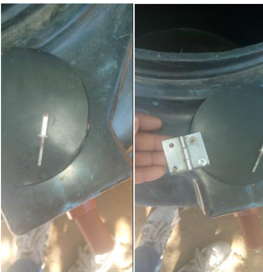
Figura 10. Montagem da tampa
