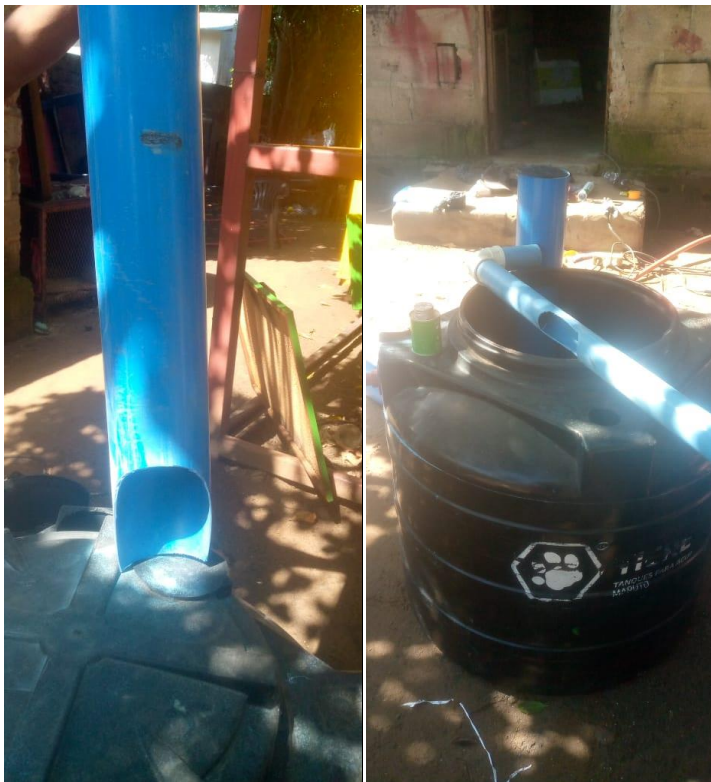
Figura 8. Preparação dos tubos
