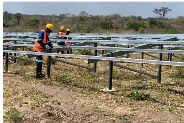
Figura 9: (a) Perfuração do solo, (b) e (c) cravamento e montagem de estruturas metálicas de suporte
