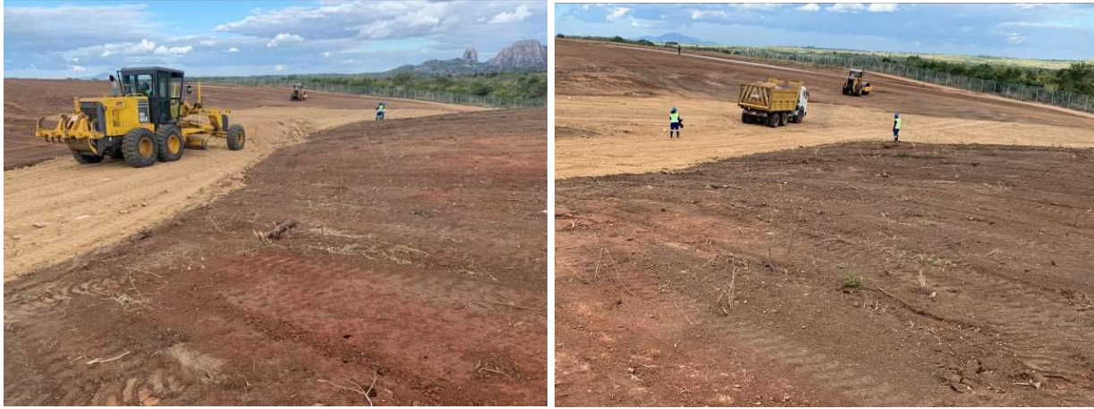
Figura 7: Preparação do terreno
