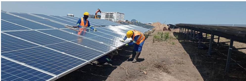
Figura 12: Fixação de painéis solares nas estruturas metálicas
