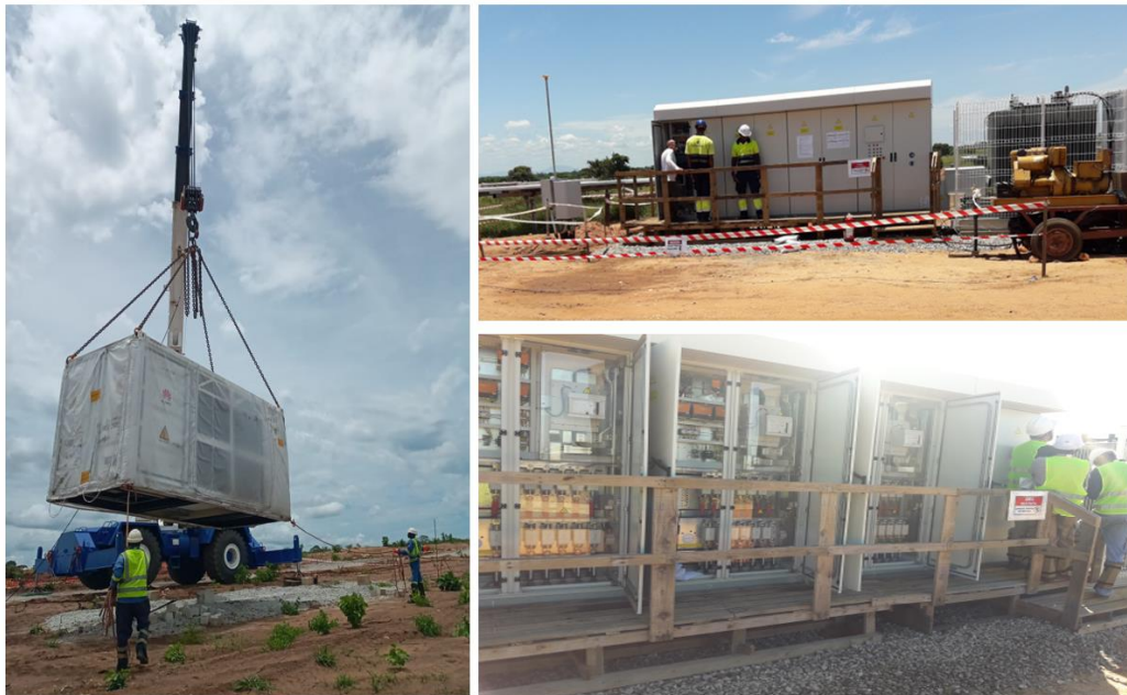
Figura 14: Descarregamento e comissionamento de estações fotovoltaicas
