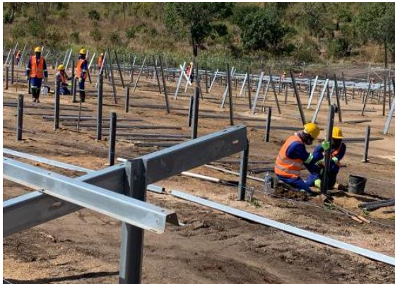
Figura 9: (a) Perfuração do solo, (b) e (c) cravamento e montagem de estruturas metálicas de suporte
