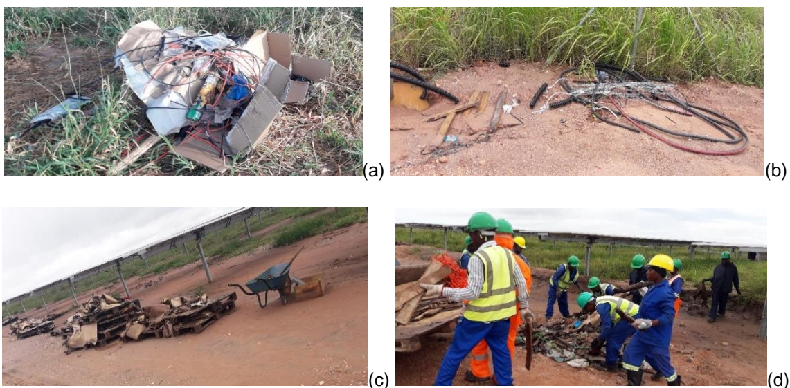
Figura 22: Recolha de resíduos ao longo da obra
