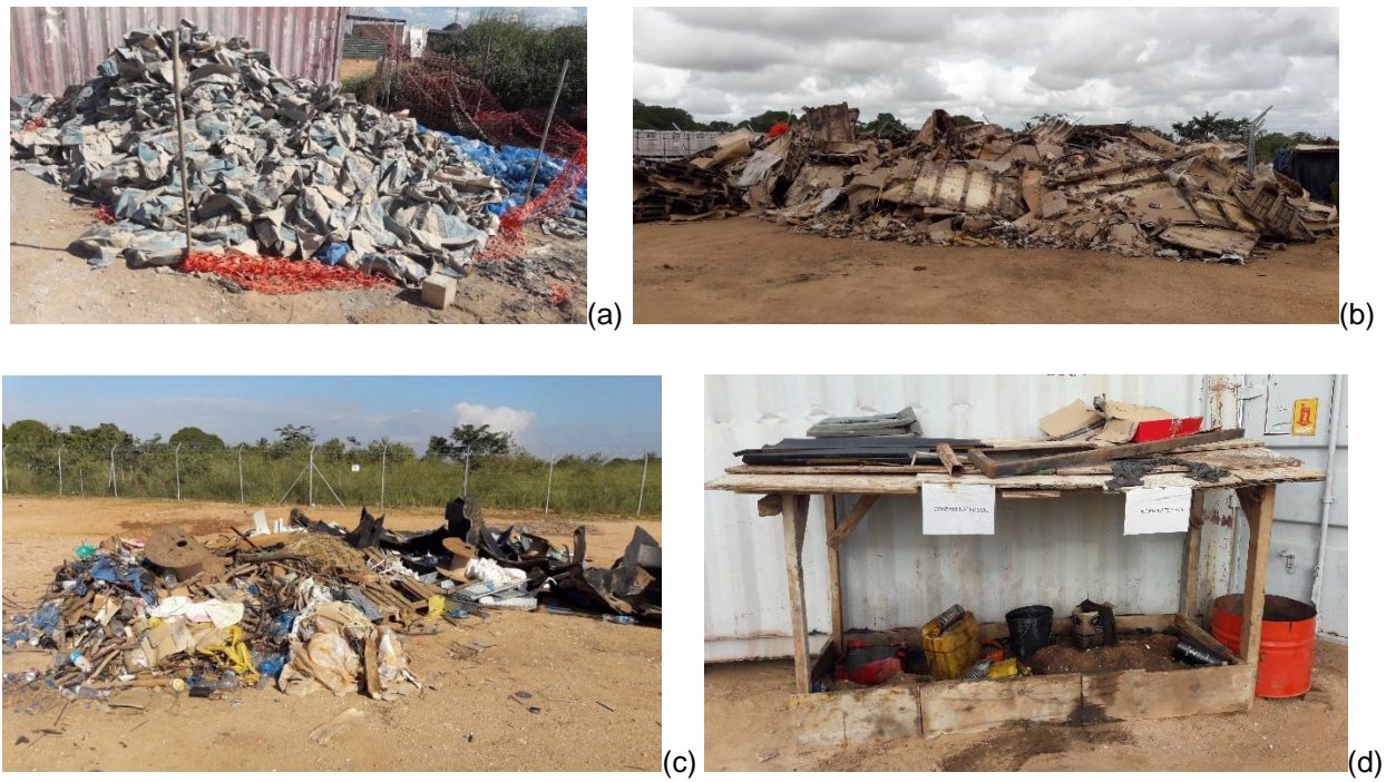
Figura 24: Acondicionamento de resíduos produzidos ao longo da obra (a), (b), (c) e (d)
