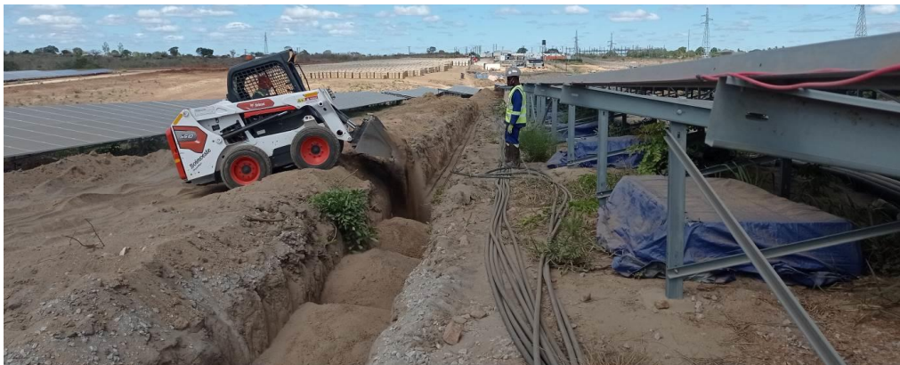
Figura 8: (a) Abertura de vala, (b) lançamento de cabo, (c) tapamento de vala
