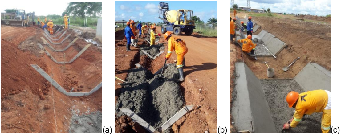
Figura 10: Construção de valetas (a), (b) e (c)
