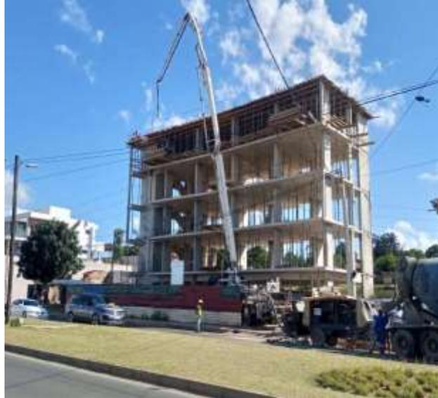
*Figura 31 – Escoramento das lajes pós-betonadas*
