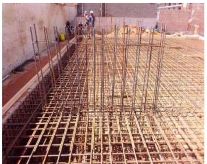
Figura 14 - Arranque de um pilar do edifício
