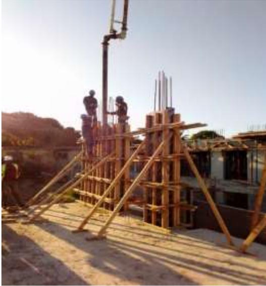
*Figura 21 – Betonagem*
