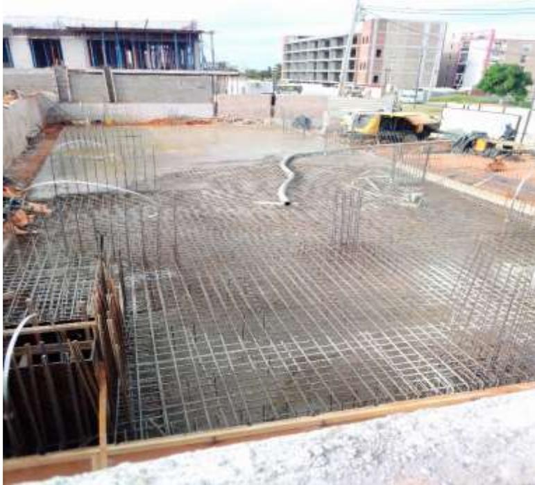
*Figura 17 – Betonagem da laje de fundação*
