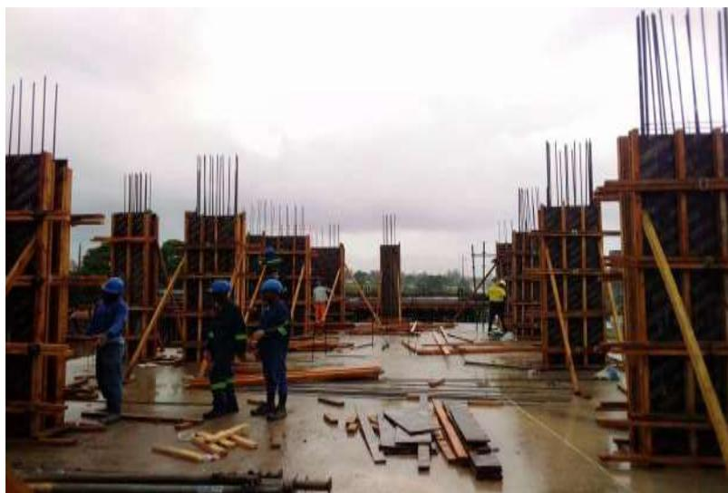
*Figura 20 – Pilares Cofrados*
