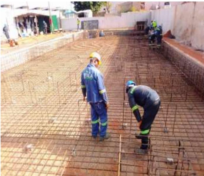
*Figura 11 – Posicionamento dos cavaletes de apoio da malha superior*
