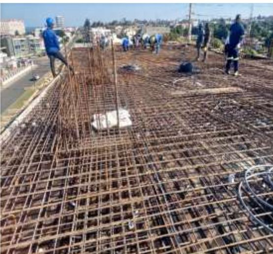
*Figura 25 – Armação armadura da laje*
