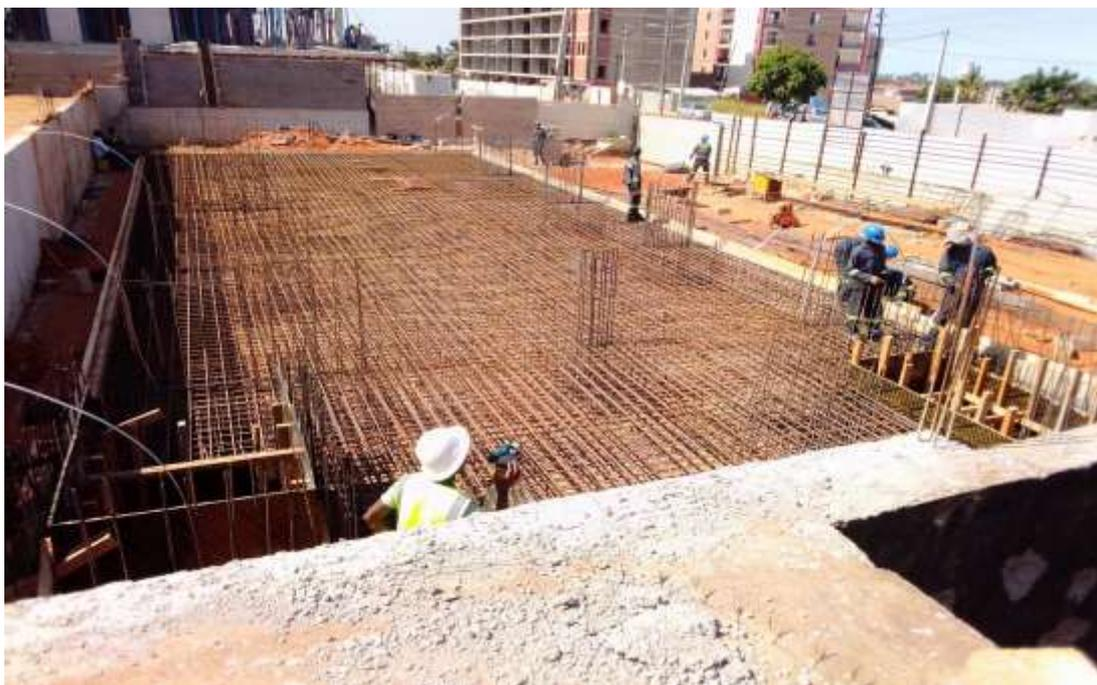
*Figura 16 - Visão geral da Fundação a betonar*
