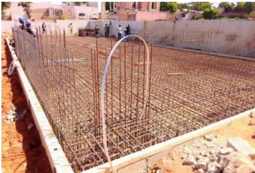
*Figura 15 – Colocação das fitas de aço galvanizado para o SPDA*
