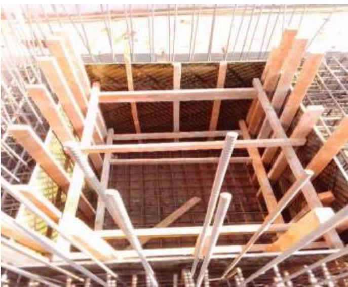
Figura 13 – Cofragem das paredes do elevador
