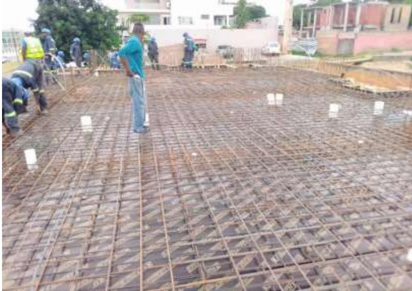
*Figura 35 – Negativos para instalação da Tubagem de esgoto*
