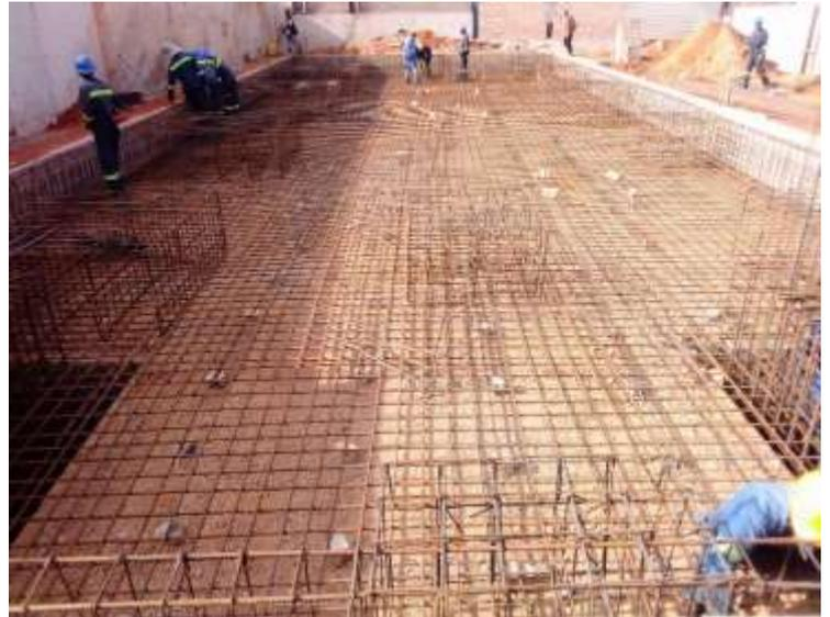
*Figura 10 – Posicionamento das bandas de reforço*
