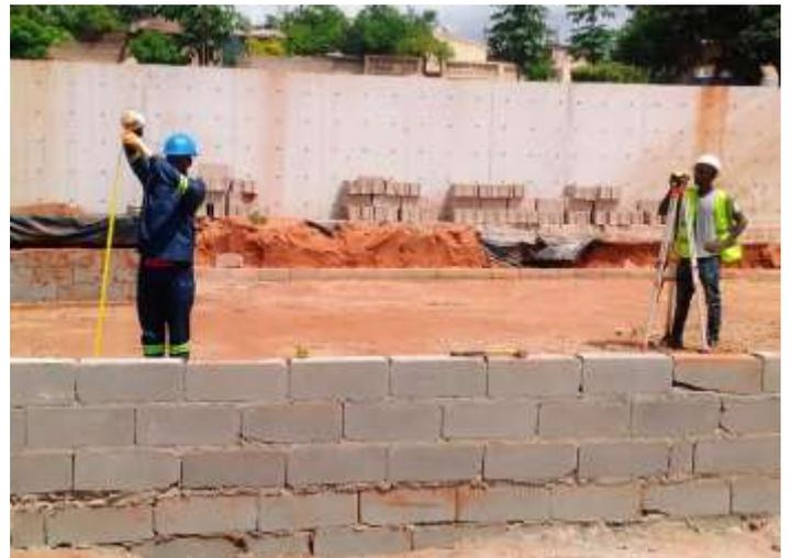
*Figura 7 – Verificação do nivelamento*
