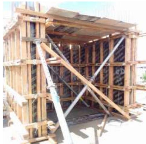
*Figura 18 – Marcação e Empalme Do Pilar* *Figura 19 – Cofragem e escoramento dos muros do elevador*
