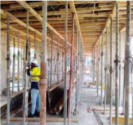
*Figura 23 – Cofragem da laje*
