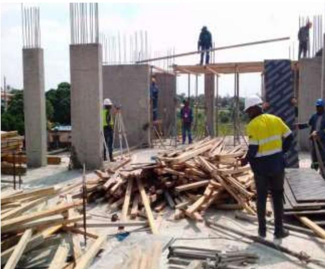
*Figura 29 – Início da cofragem da laje*
