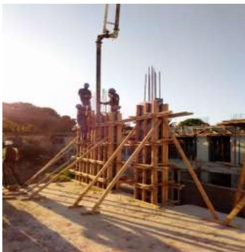
*Figura 28 - Cofragem de um pilar*
