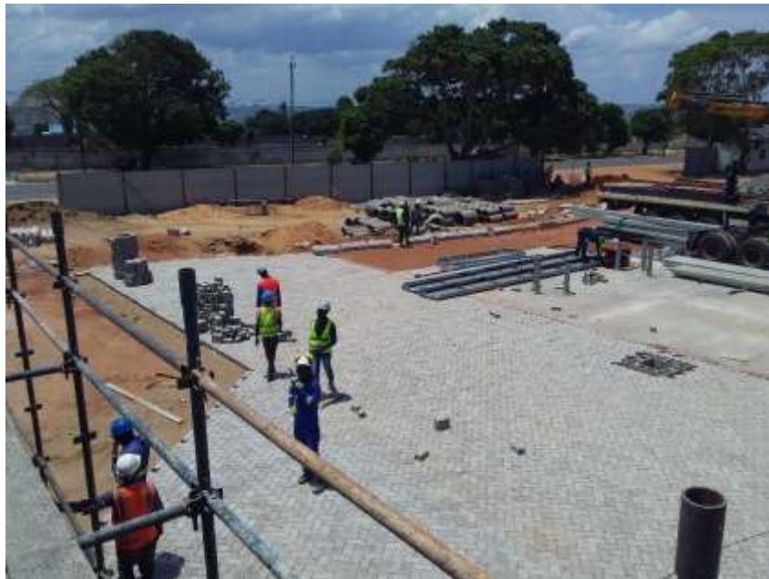
Fotografia 16_ Assentamento do pavê
