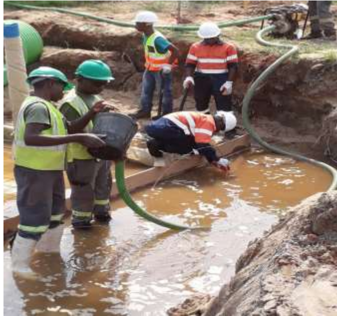
Fotografia 9_ Bombeamento da água.
