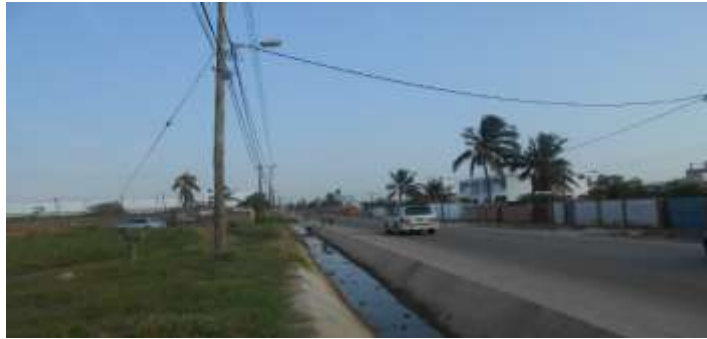
Fotografia 2_Vala de drenagem existente.
