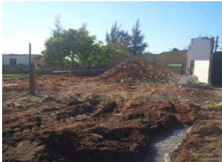
Fotografia 10_Remoção de terra vegetal.
