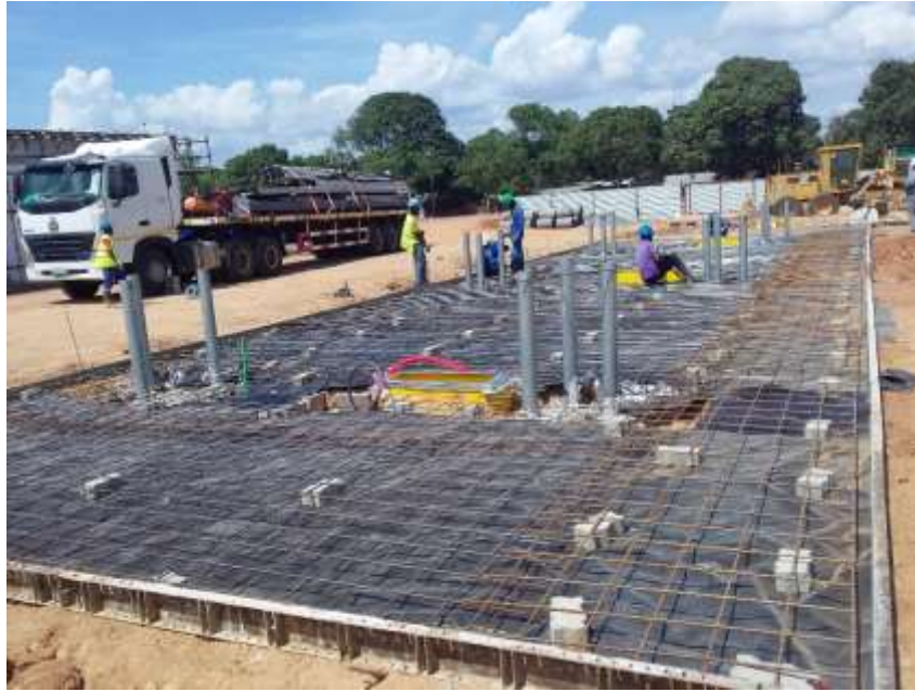
Fotografia 13_Preparação do pavimento da canopy.
