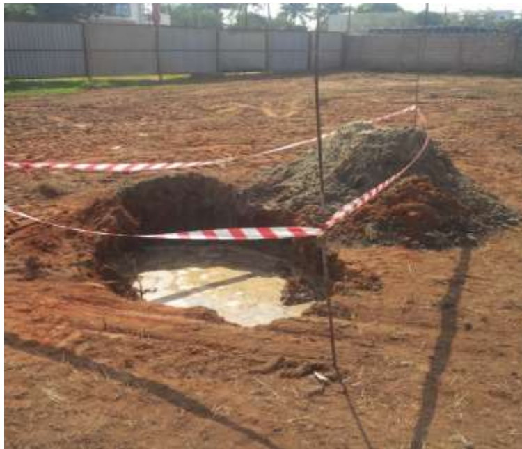
Fotografia 11_ Poço para controlo do lençol freático.
