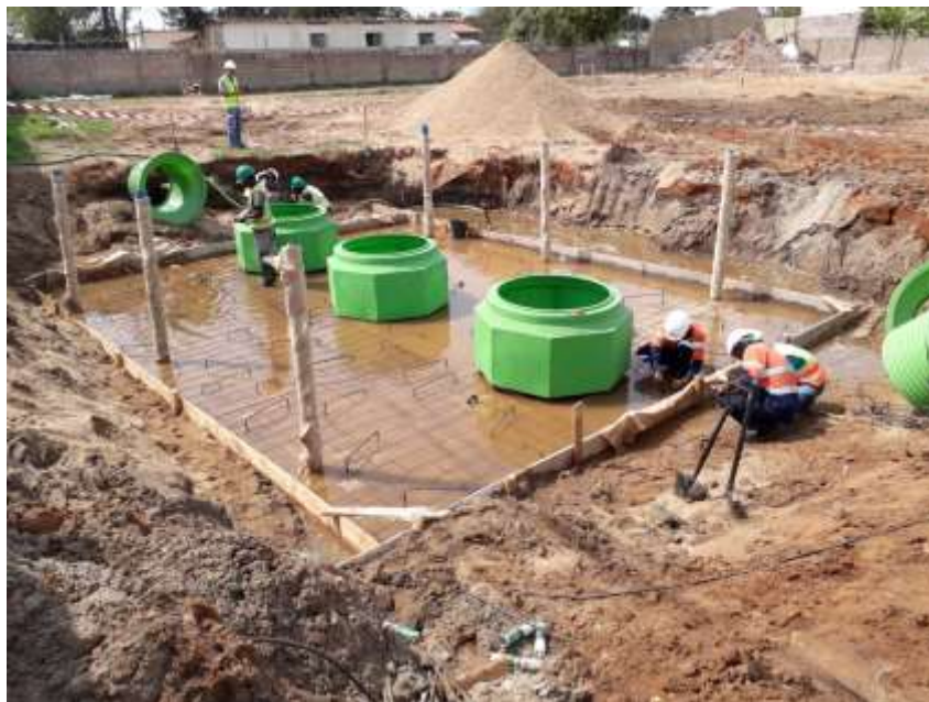
Fotografia 6_ Execução laje de topo.
