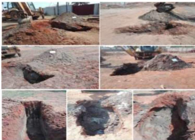
Fotografia 4_Vista dos poços de investigação após escavação.
