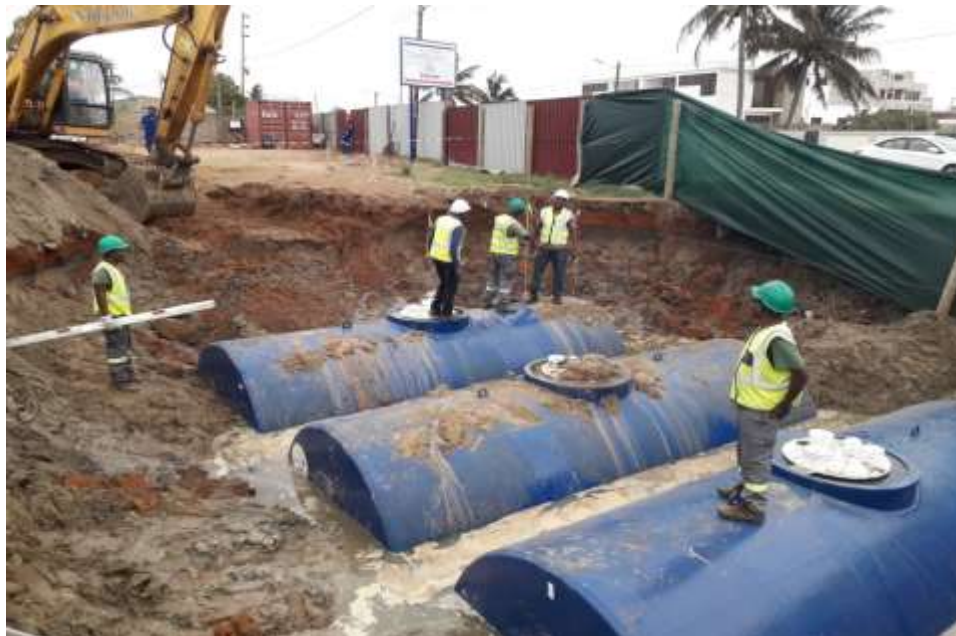
Fotografia 8_ Instalação de depósitos
