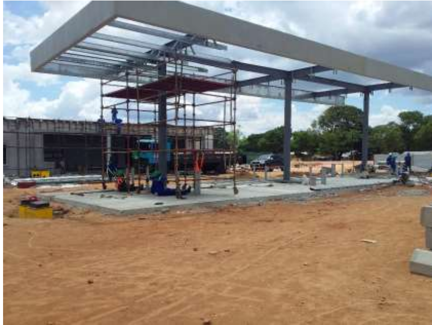
Fotografia 15_Construção da canopy.
