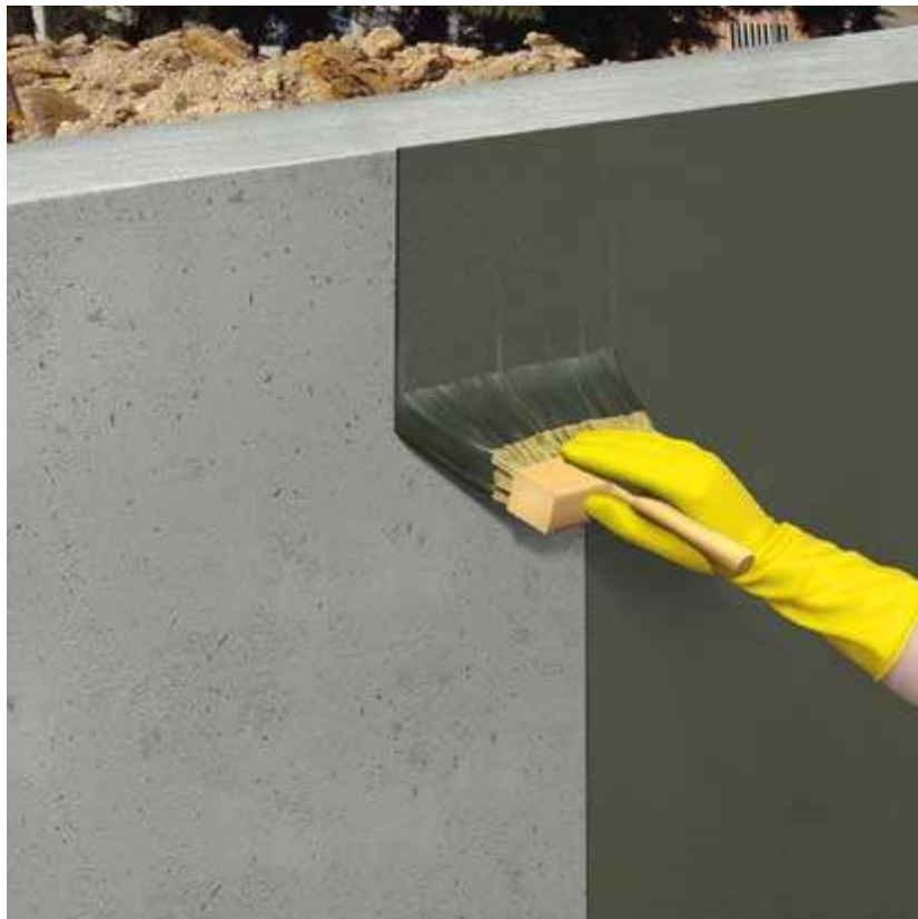
Fotografia 12_Aplicação da impermeabilização em superfícies de betão.
