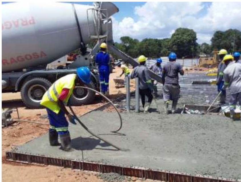
Fotografia 14_Aplicação e vibração do betão
