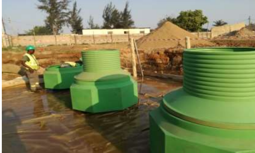
Fotografia 7_ Instalação da Sump
