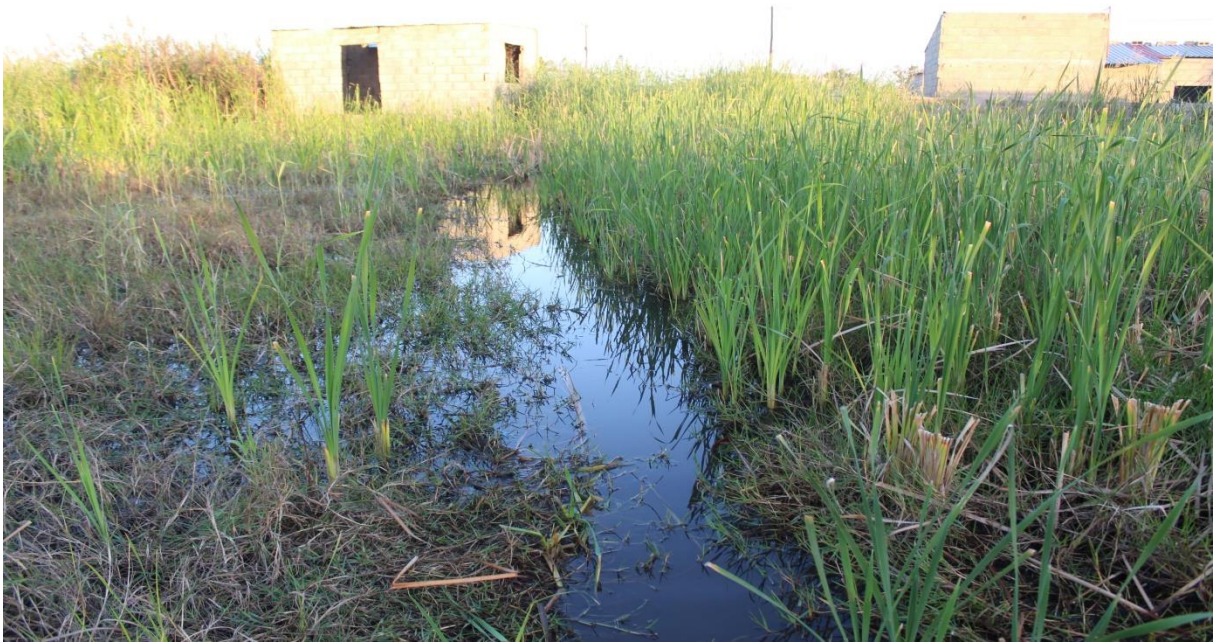
Figura 3: Residências construídas em linhas naturais de água inundadas.
