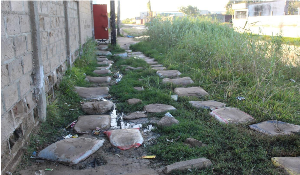
Figura4: Perfilamento de sacos contendo areia para servir de passadeira
