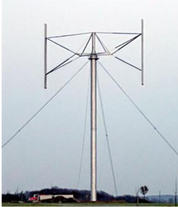
**Figura 10: Aerogerador de eixo vertical do tipo Giromil. Fonte: [10]**
