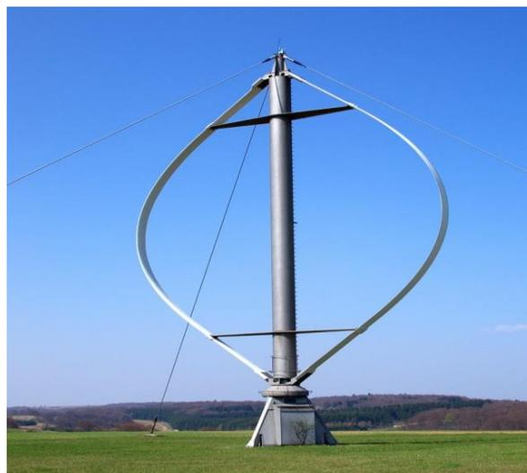
**Figura 8: Turbina de eixo vertical do tipo Darrieus. Fonte: [10]**
