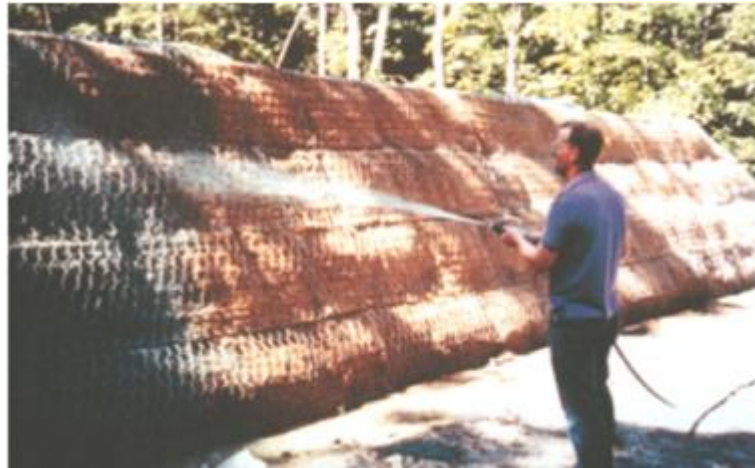
Figura 16: Execução da Hidrossemeadura
