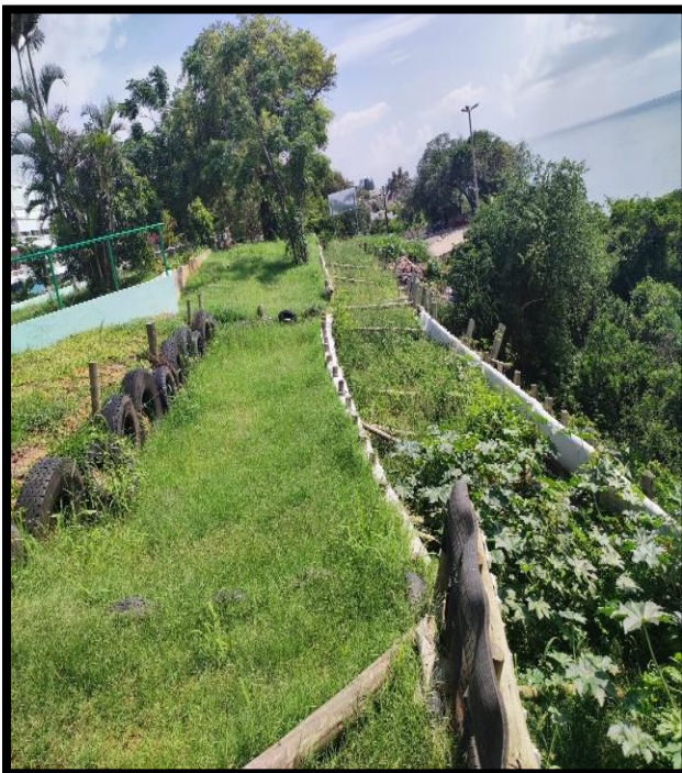
Anexo 2: Talude Ponta vermelha estabilizado na crista
