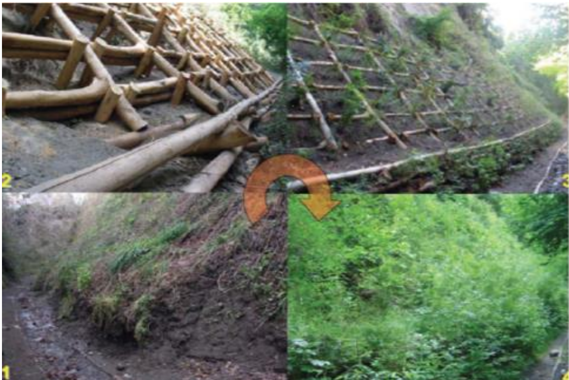
Figura 31: Construção da Grade Viva: 1) Talude avariado; 2) Gradeamento de madeira; 3) Estacas vivas entre o gradeamento; 4) Grade Viva com a vegetação já desenvolvida
