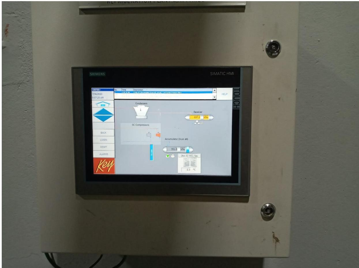
**Figura 5:** Painel de Controlo de ciclo de refrigeração
